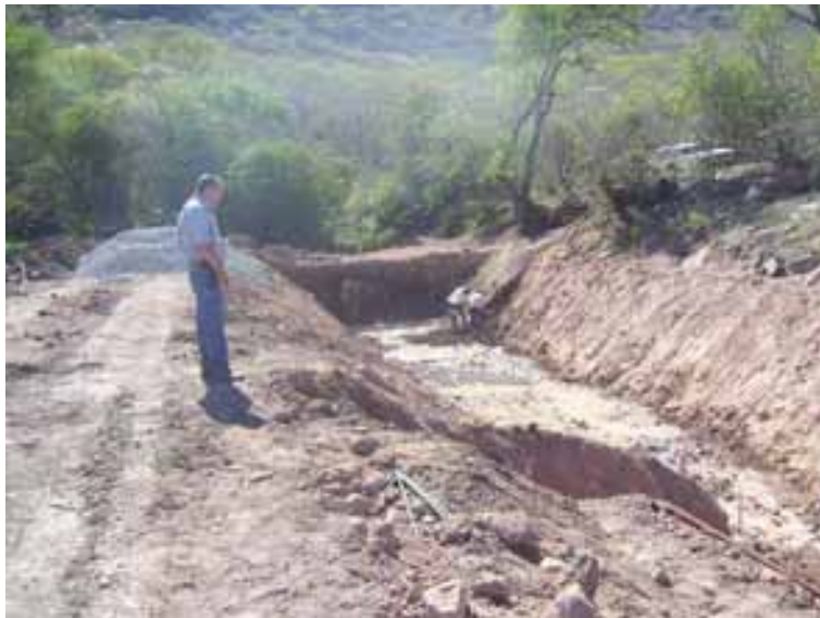
Foto 4.25 Trabajos previos a la construcción del vertedor.
