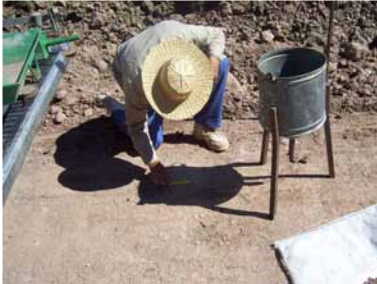
Foto 4.14 Nivelación de la arena con el terreno “Prueba de Campo”.
