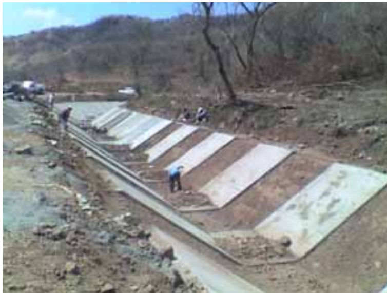
Foto 4.22 Limpieza para el colado de nuevas losas.
