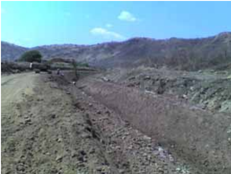
Foto 4.16 Excavación de cubeta con retroexcavadora.
