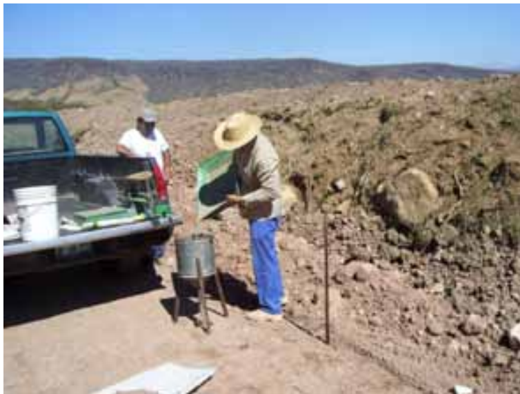
Foto 4.13 Relleno con arena de peso volumétrico constante “Prueba de Campo”.
