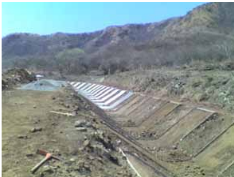
Foto 4.20 Colocación de cerchas y colado de losas.
