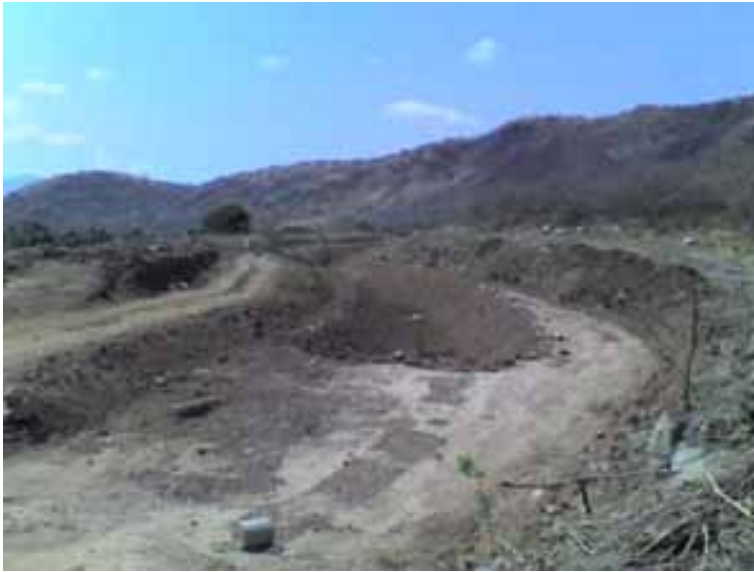
Foto 4.15 Excavación de cubeta.
