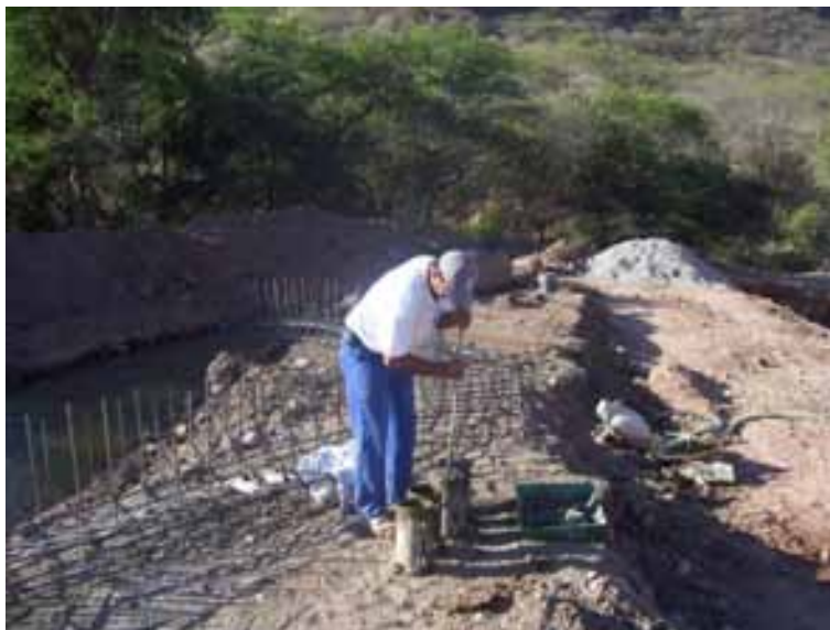
Foto 4.19 Elaboración de cilindros de concreto.
