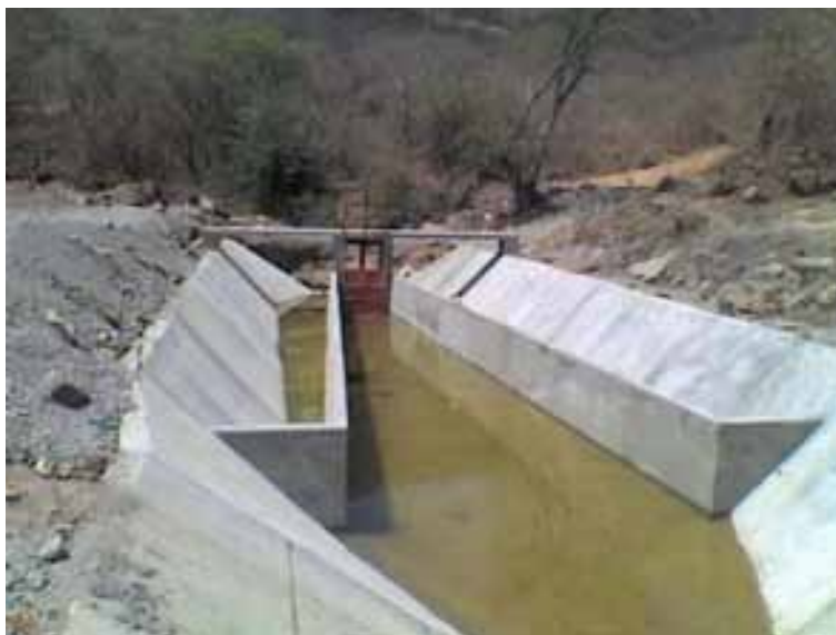
Foto 4.26 Vertedor en operación.
