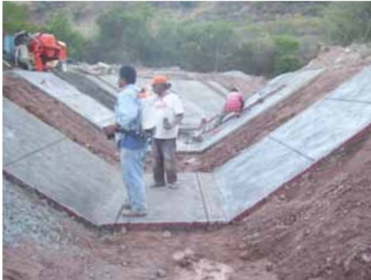
Foto 4.21 Colocación de membrana de curado.
