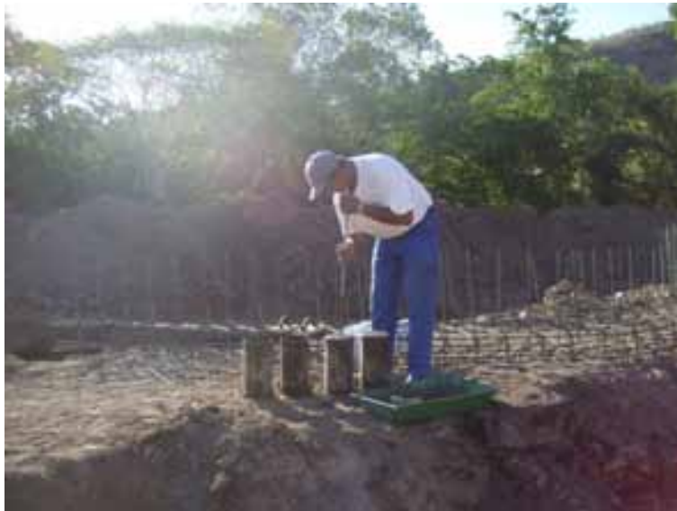
Foto 4.18 Elaboración de cilindros de concreto.
