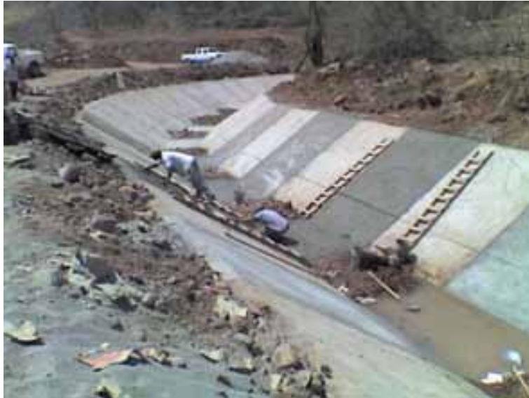
Foto 4.23 Colado de losas.
