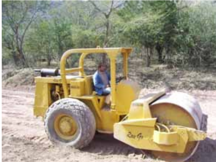
Foto 4.10 Compactación de material de terraplén.
