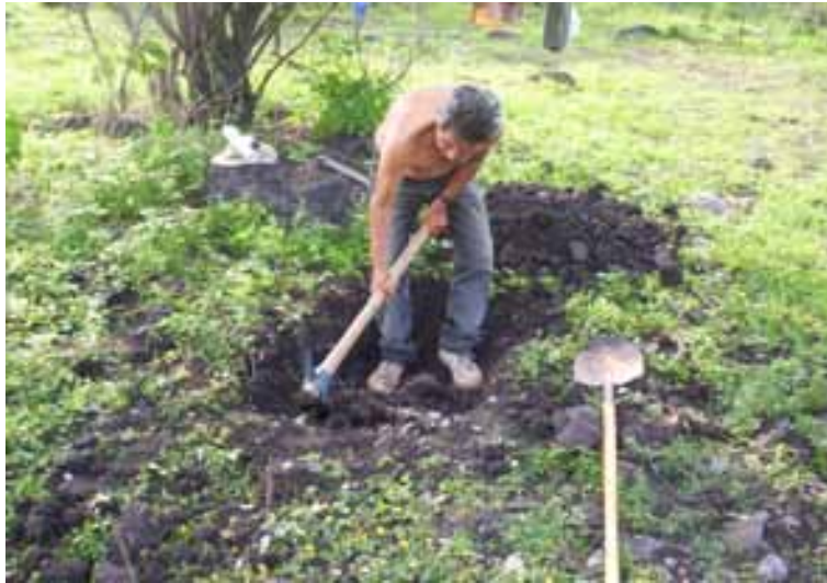
Foto 4.1 Excavación pozo de sondeo para banco de material.
