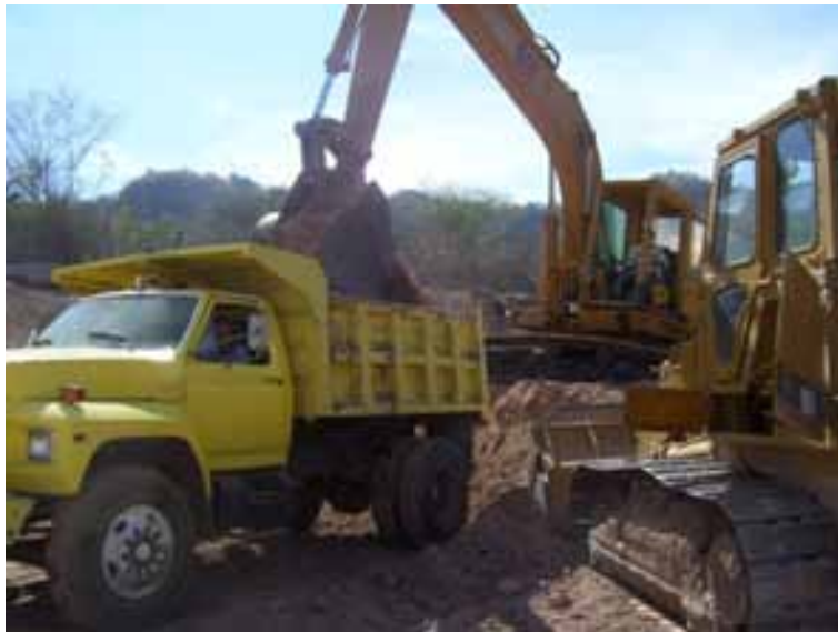
Foto 4.7 Explotación de Banco de Terraplén. “La Loma”.
