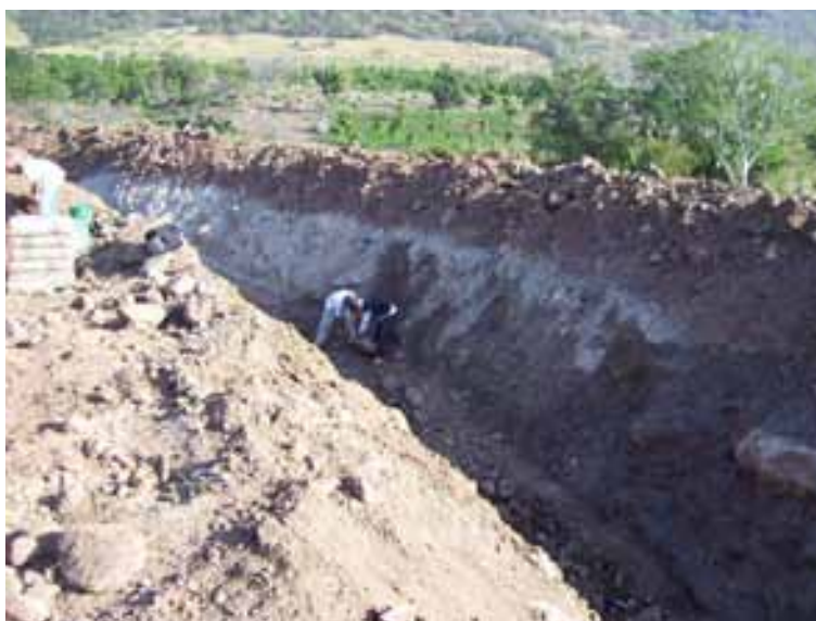
Foto 4.27 Trabajos para la estabilización de suelo.
