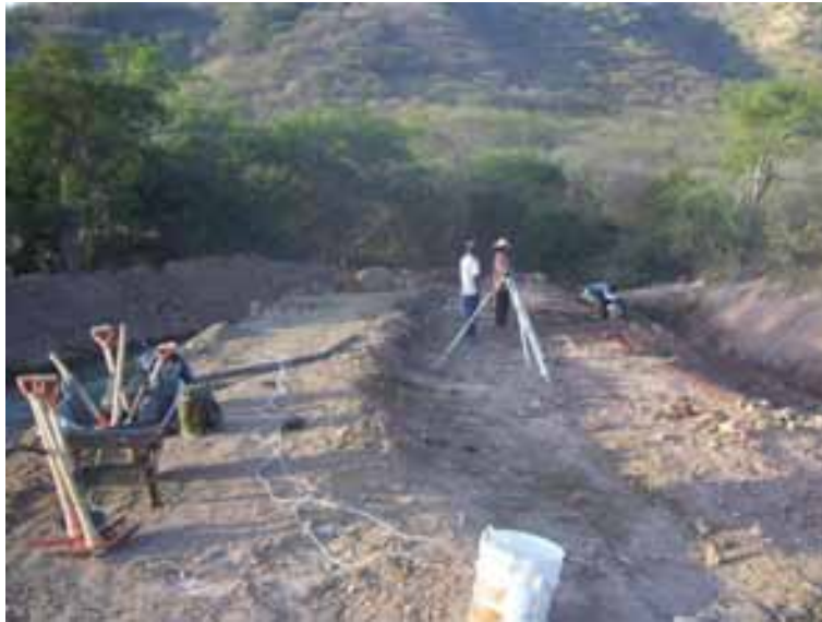
Foto 4.24 Trazo para construcción del “Vertedor Pico de Pato”.
