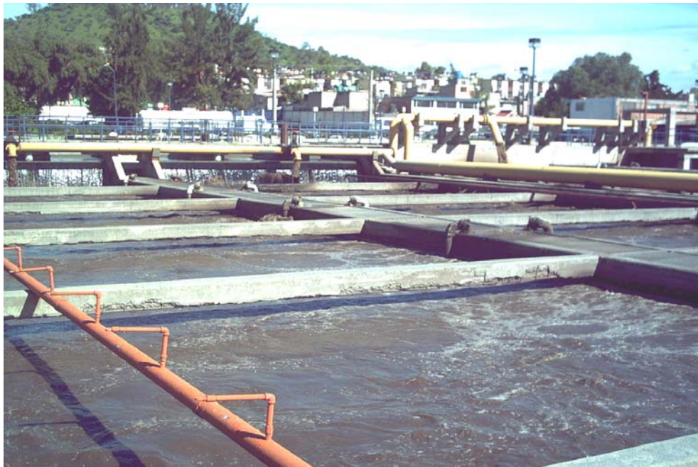
Figura 4.1 Planta de tratamiento de aguas residuales “Cerro de la Estrella”
