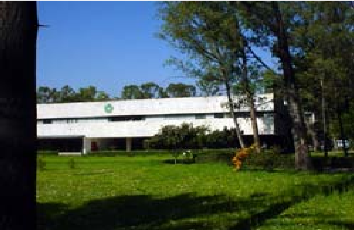
Vista interior del DIE
