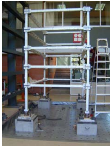
c. Instalación del marco de acero sobre la MV
