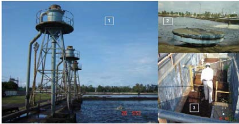
Figura 2. Fotografías tomadas en la zona de muestreo. 1) Hiperaireadores en laguna de oxidación. 2) Aireadores mecánicos en laguna de oxidación. 3) Punto de muestra 2, influente a laguna de oxidación.
