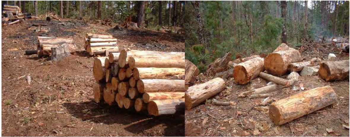
Figura 25. Saneamiento 2007; A) derribe y troceado
