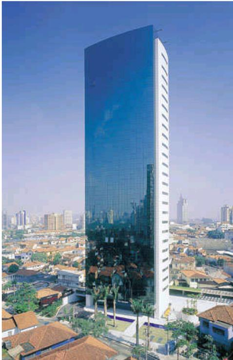
FIGURA 2.1 Edificio muy esbelto con estructura de concreto reforzado. La resistencia y rigidez ante cargas laterales es proporcionada esencialmente por muros de concreto acoplados. (Ref. 1)
