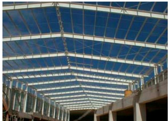
FIGURA 3.2 Cubierta mediante marcos rígidos de acero estructural.
