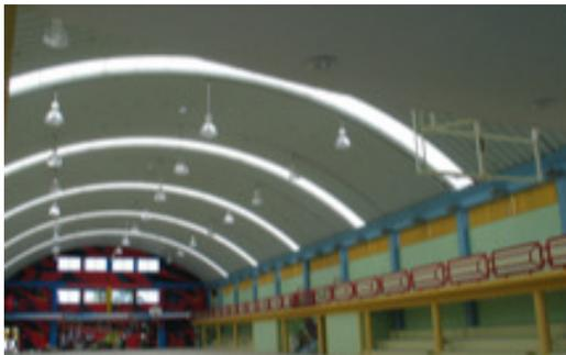
FIGURA 3.1 Cubierta Auto soportante.
