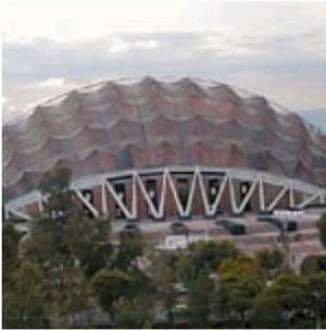
FIGURA 2.3 Palacio de los Deportes de la Ciudad de México (1968). Cubierta con claro mínimo de 132 m resulta con una retícula de arcos metálicos de alma abierta. (Ref. 1)
