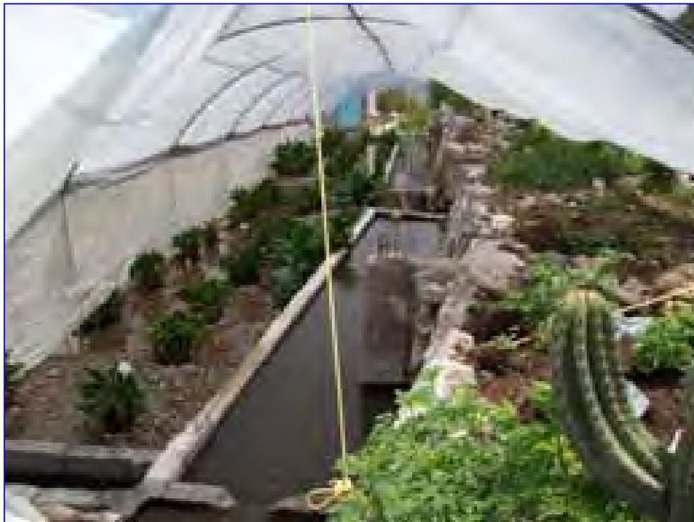
**Figura 8. Sedimentadores de agua en el Humedal construido**
