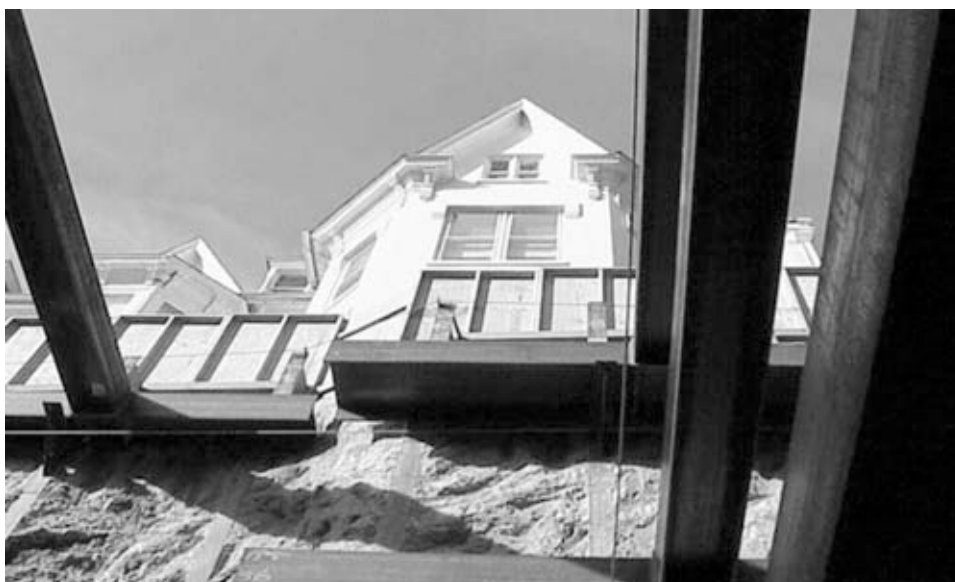
En trabajos adyacentes a construcciones históricas estas técnicas son de gran utilidad. De hecho existen algunas obras arquitectónicas que usan estas técnicas acompañadas de un adecuado diseño.
