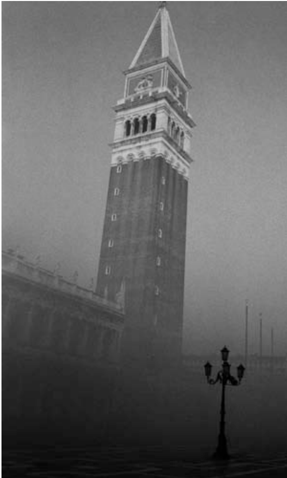
El Campanario, después de derruido, permanece, tal cual como lo construyeron en el siglo XVI.
