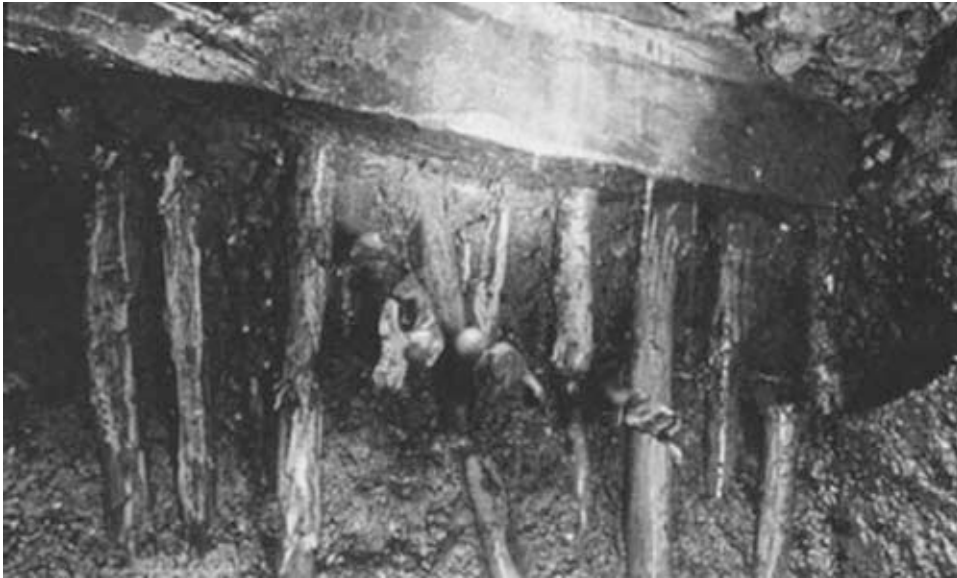
Vestigios de estacones de madera como prueba de la vieja técnica para cimentar edificios.
