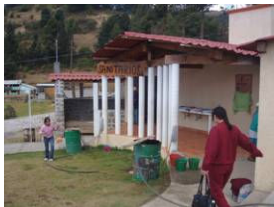
Instalaciones sanitarias, de centro turístico Angangueo, Michoacán
