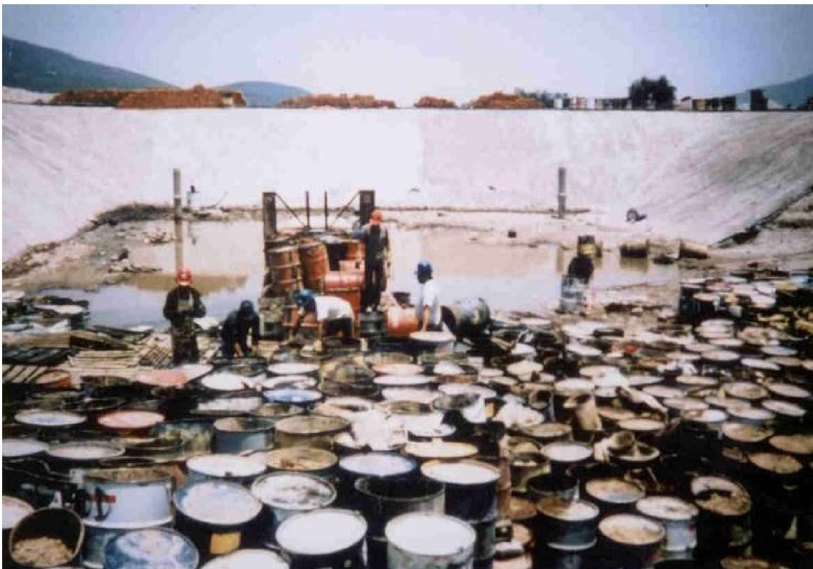
Fotografía 16. Tambos y agua percolada en una celda en el predio de La Pedrera
