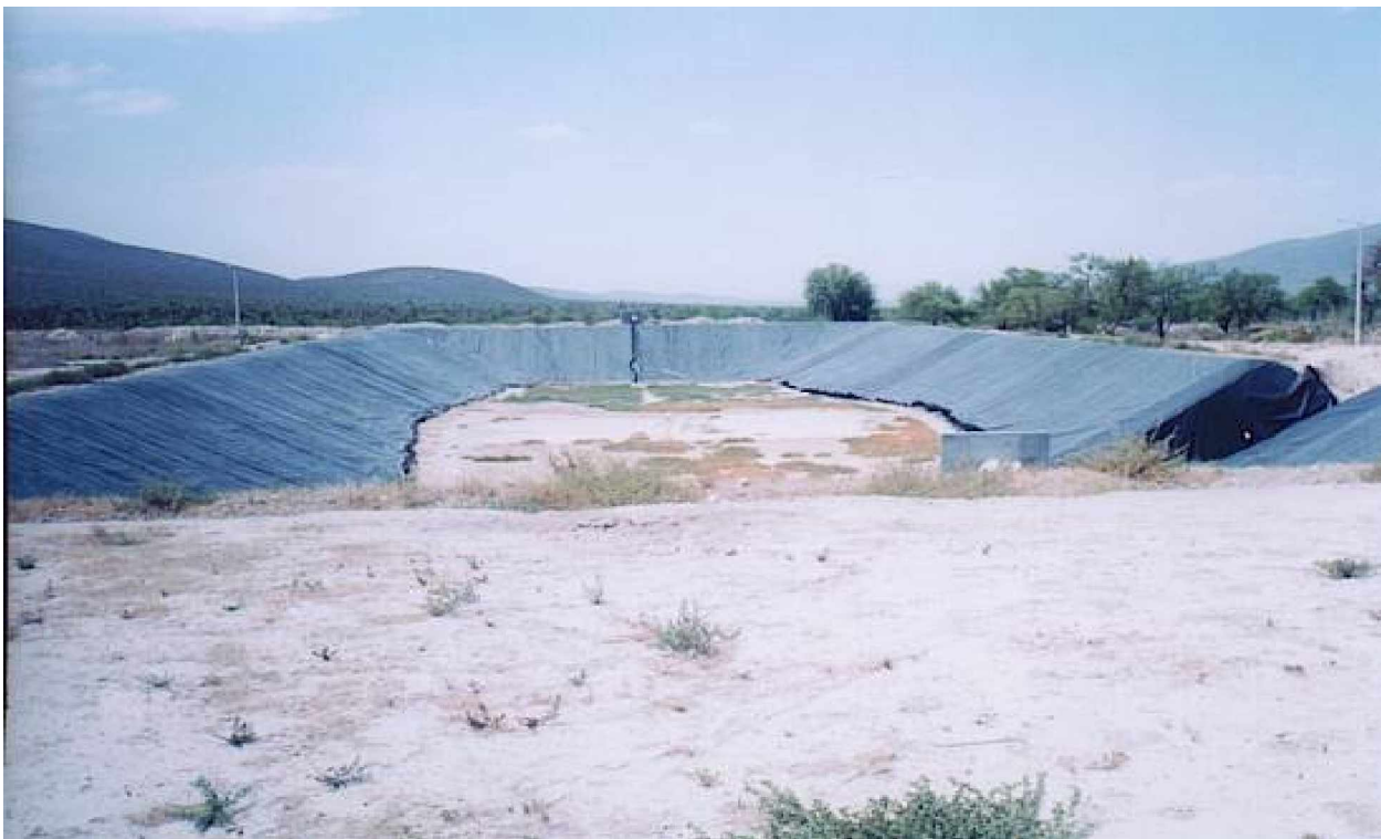
Fotografía 14. Celda de confinamiento recubierta por la SEDUE
