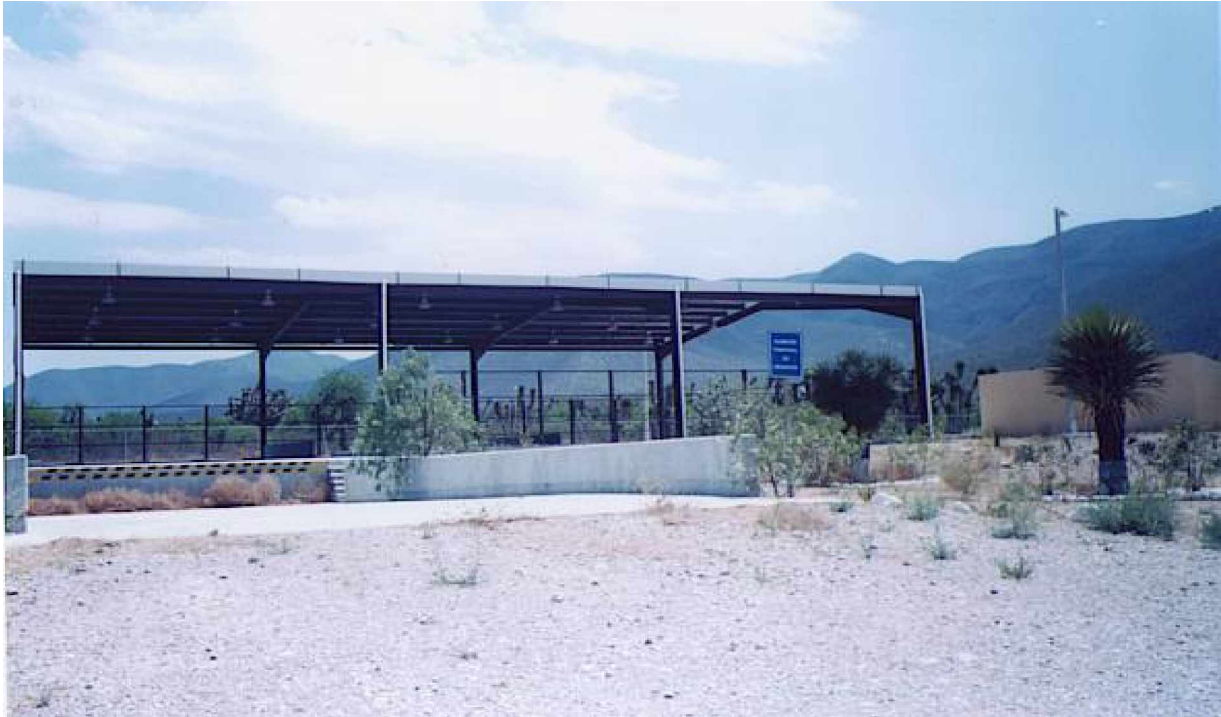
Fotografía 17. Zona de descarga construida dentro del confinamiento
