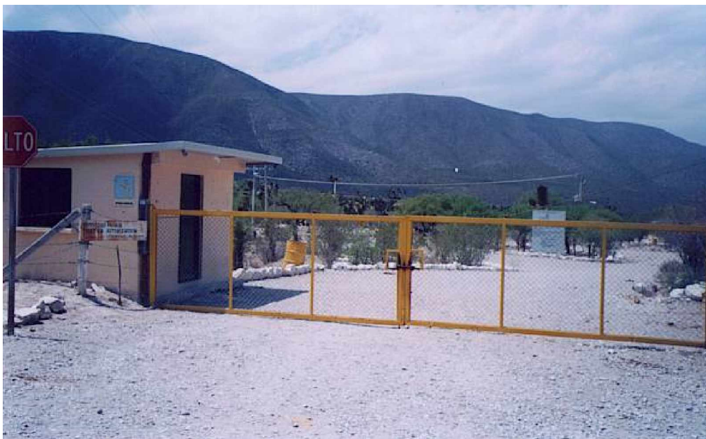
Fotografía 4. Acceso al sitio de La Pedrera, lugar del confinamiento operado por COTERIN
