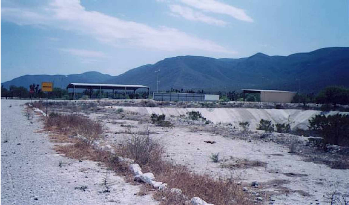
Fotografía 23. Instalaciones y celda de confinamiento en La Pedrera, Guadalcázar
