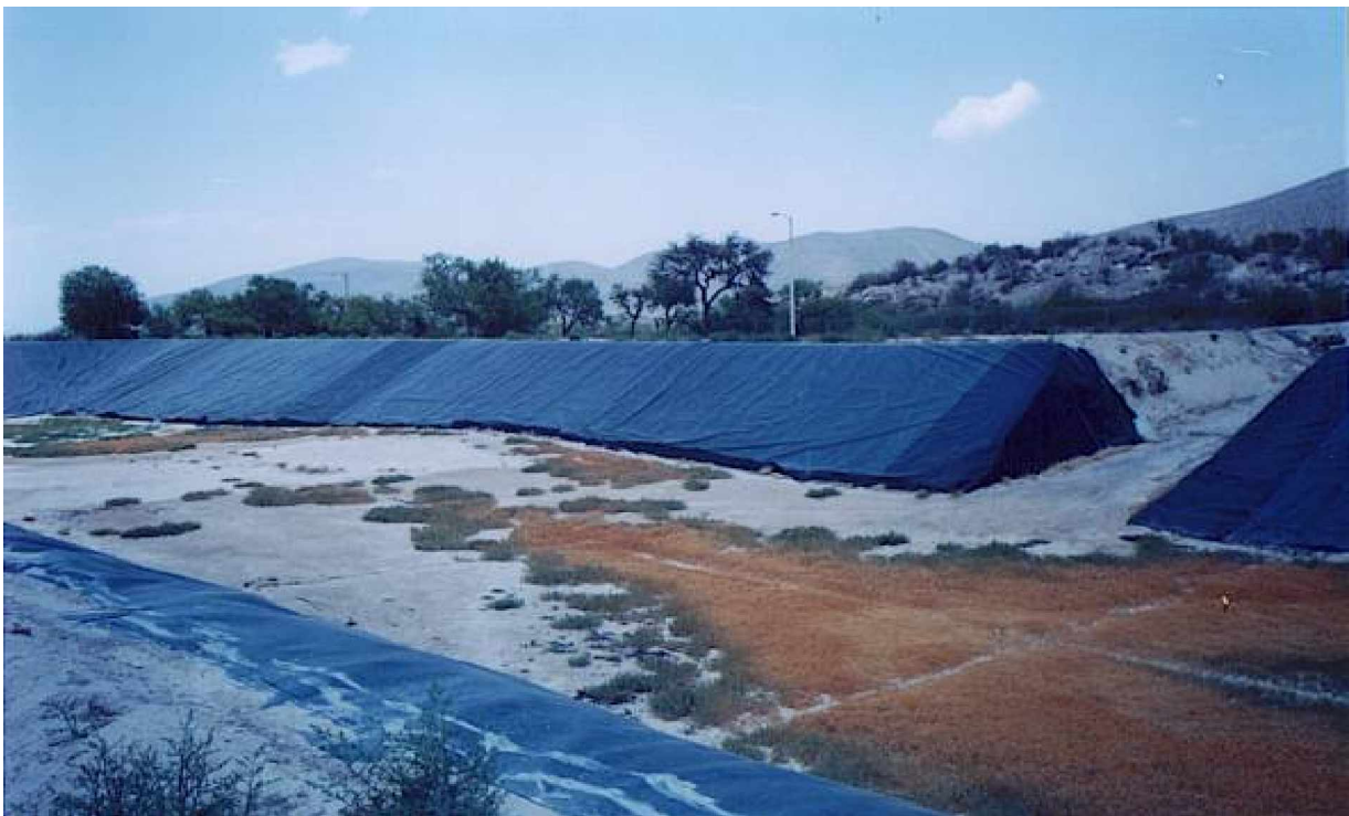
Fotografía 18. Vista de una de las celdas en el confinamiento de La Pedrera, Guadalcázar
