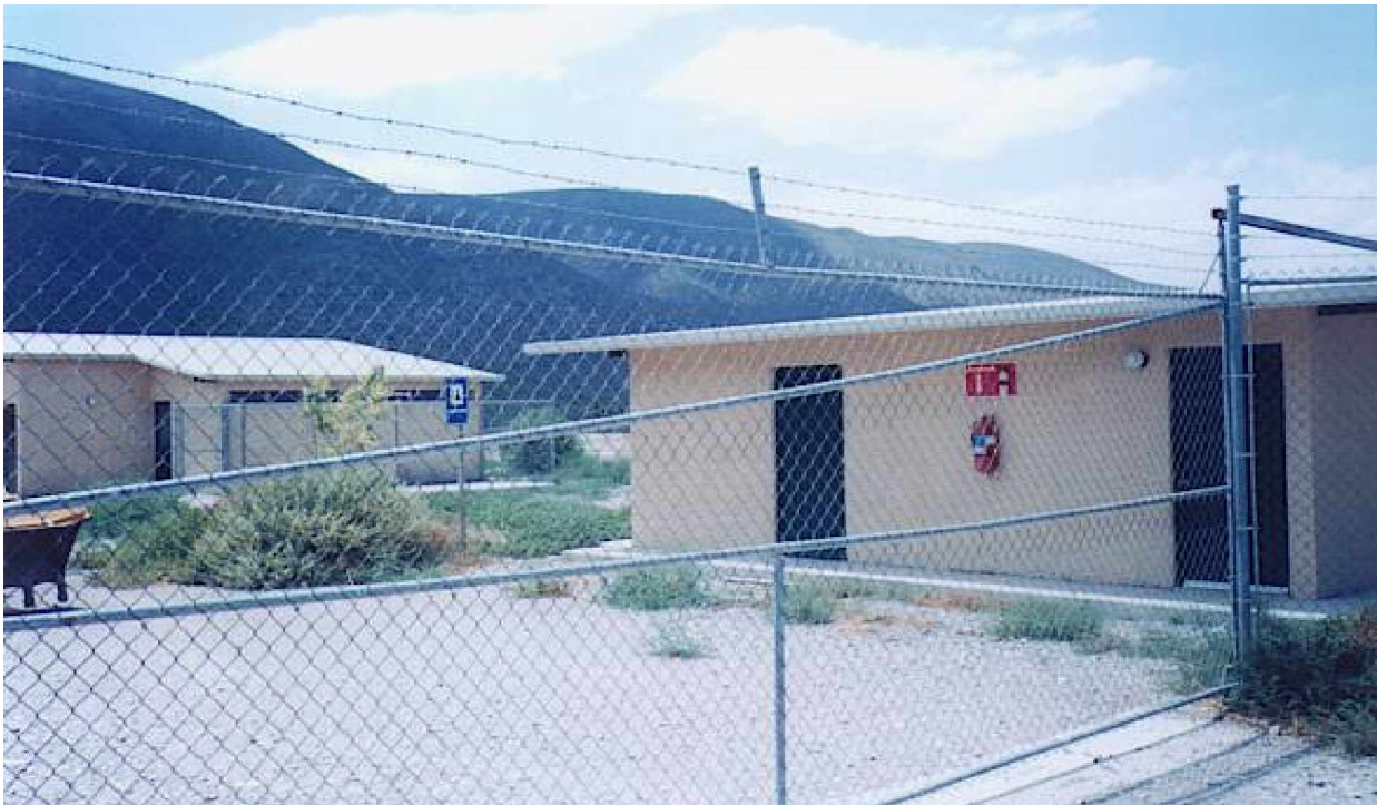
Fotografía 12. Infraestructura de la empresa COTERIN en el sitio de La Pedrera
