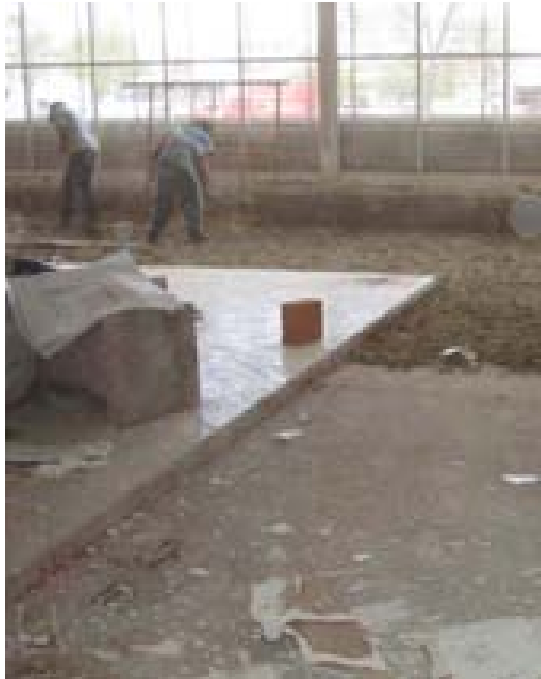
Nivelación de piso
