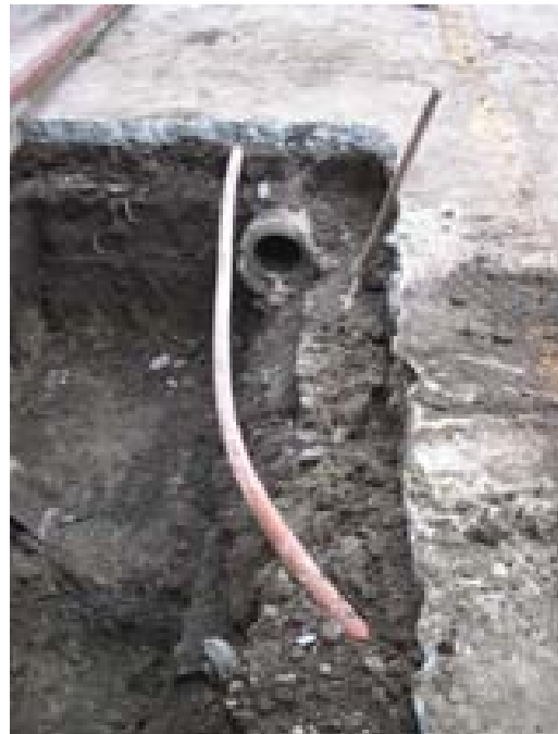
Preparación de instalaciones Sanitarias
