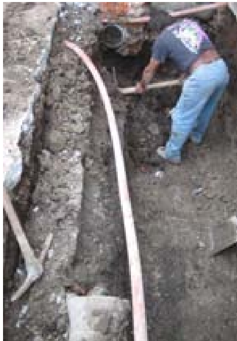
Preparación de instalaciones Telefónicas
