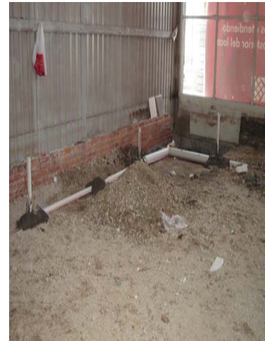
Preparación de instalaciones Sanitarias
