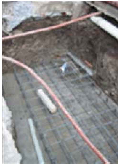
Armado de Zapata
