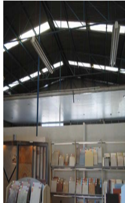
Estructura de cubierta
