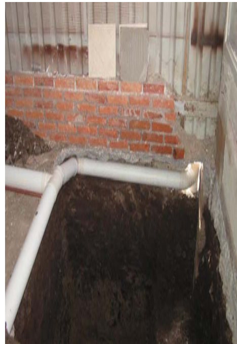
Preparación de instalaciones Sanitarias
