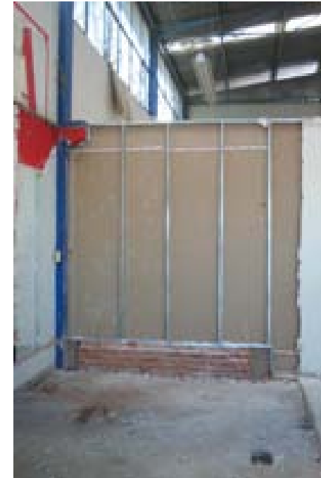
Desmante de tabla roca
