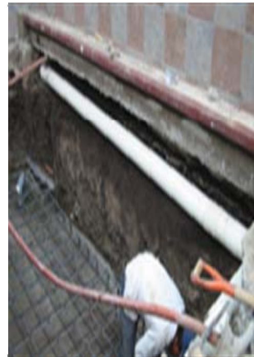
Habilitación de acero de Zapata
