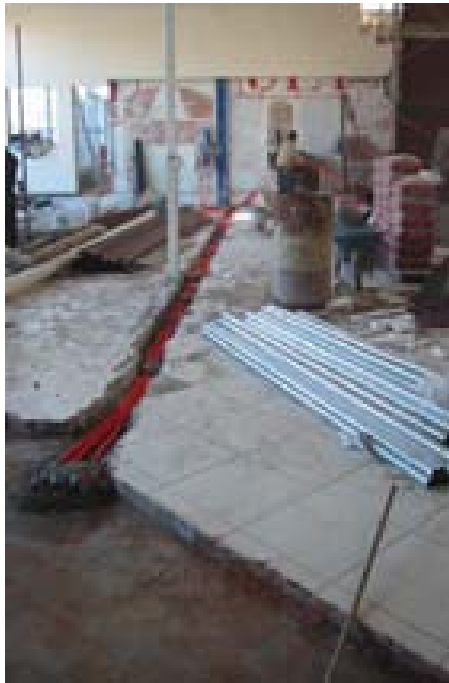
Preparación de instalaciones Eléctricas
