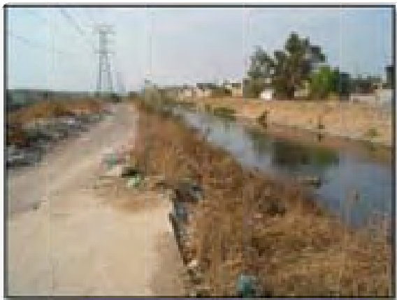
Figura 9a. Canal de aguas residuales “ Canal de la Compañía ”.
