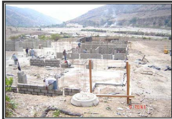
Foto 3.3 Construcción del fraccionamiento Vida Mejor III
