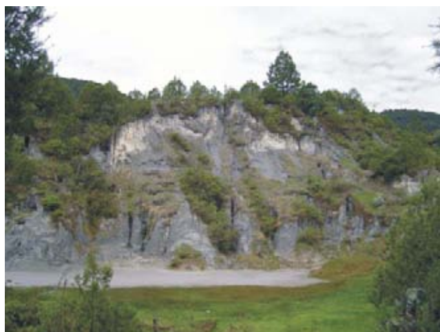
Fig. 9 Vista panorámica de un depósito de jales en El Oro, el espesor de la columna mostrada es de aproximadamente 15 metros
