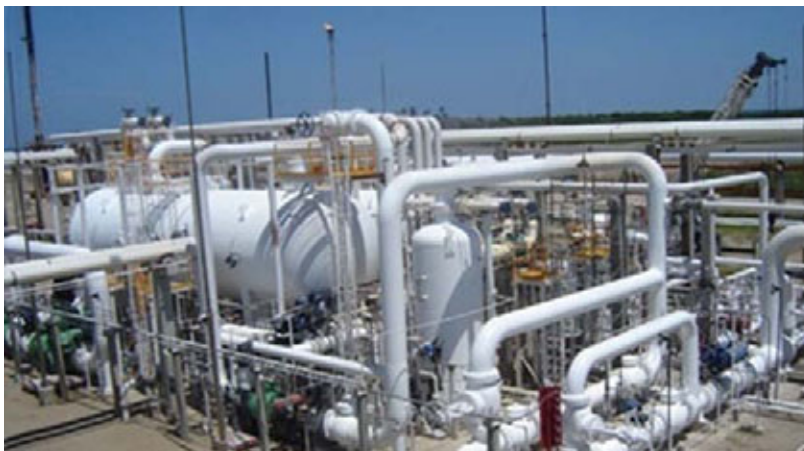
Figura 2.51. Separador Horizontal.
