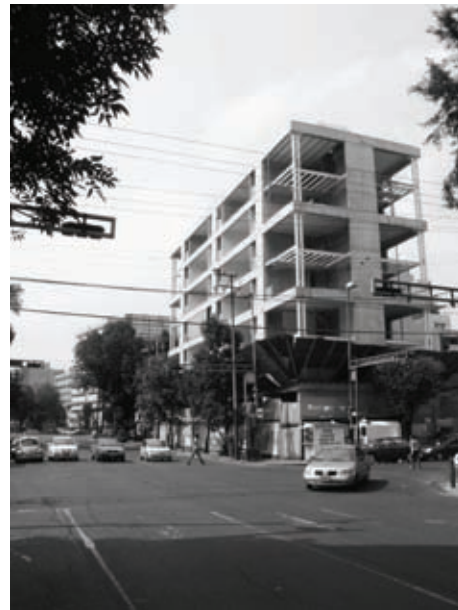
Vista de obra del exterior
