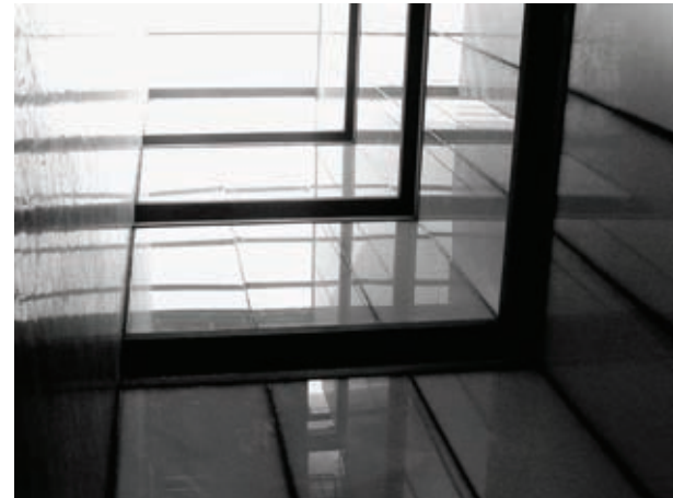
Vista de obra del patio central
