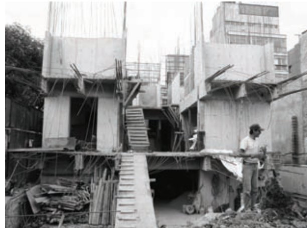
Vista de obra de las cartelas
