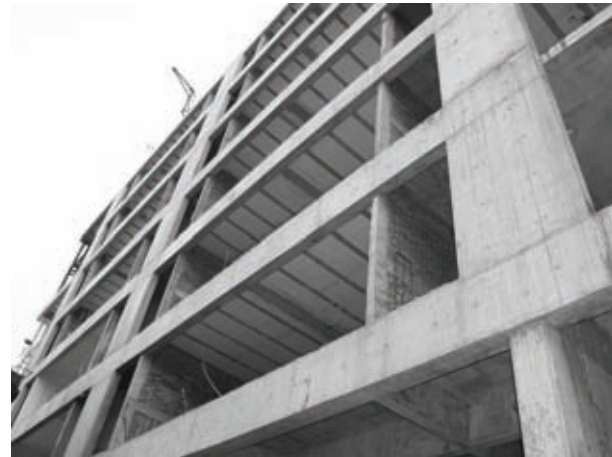
Vista de obra de la fachada
