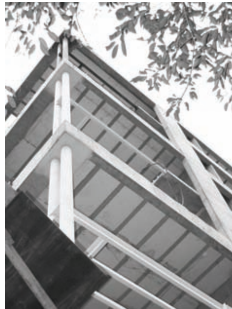
Vista de obra de la fachada
