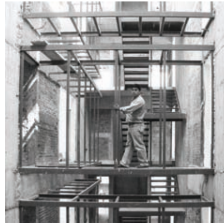
Vista de obra de los puentes
