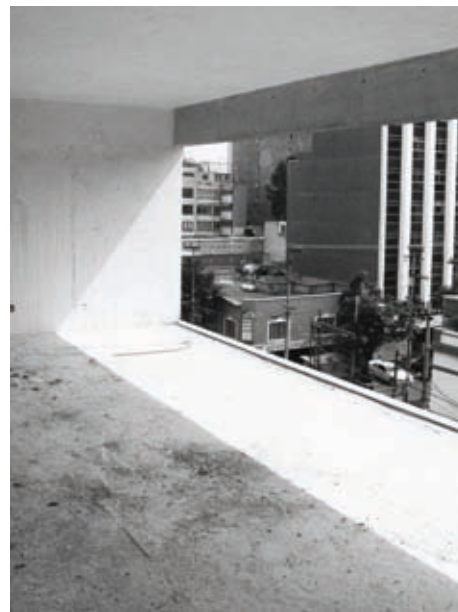
Vista de obra del interior
