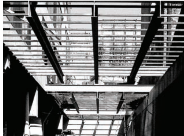
Vista de obra del patio lateral
