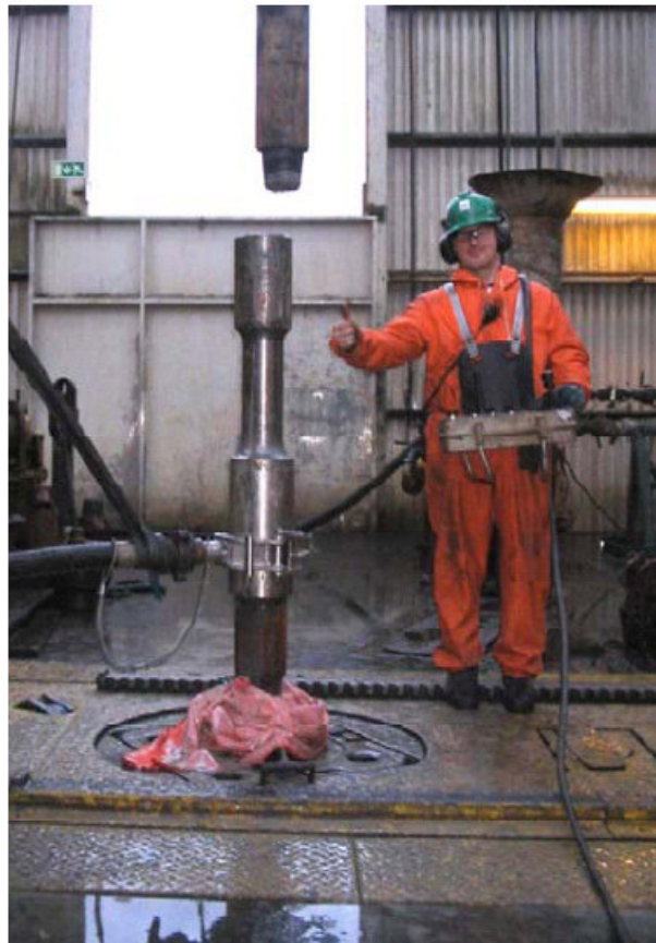
Figura 3.28. Conexión de tubería mientras se suministra flujo de lodo a través de la CCV
