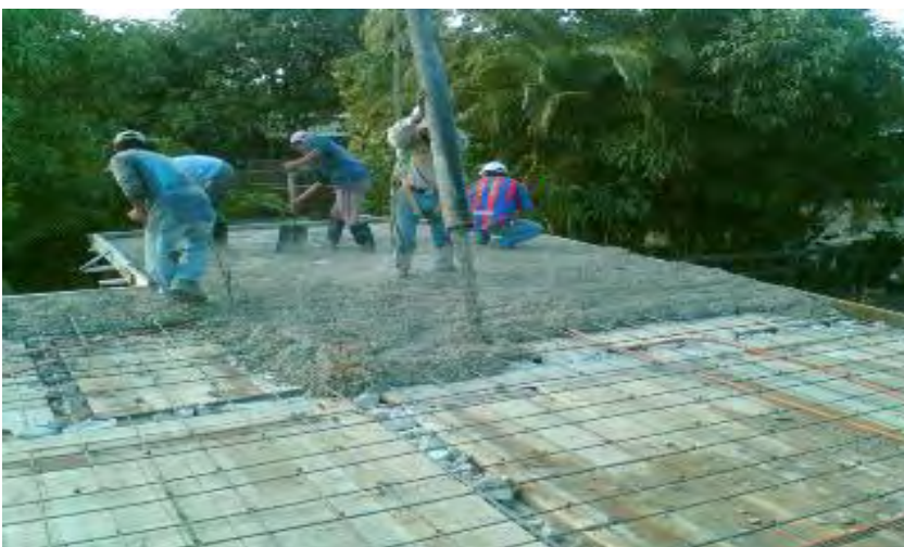
Gráfico 4. Colado de techo de concreto armado.
