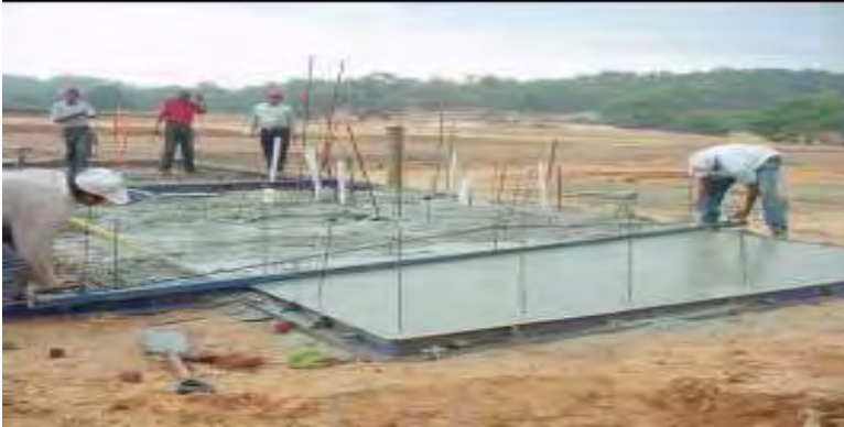
Gráfico 8. Colado de cimentación
