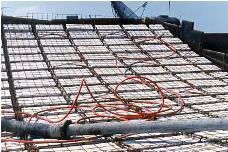
Gráfico 20. Componentes de techo aligerado en una dirección.
