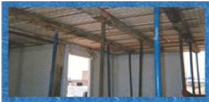
Gráfico 6. Cimbrado del techo de panel
