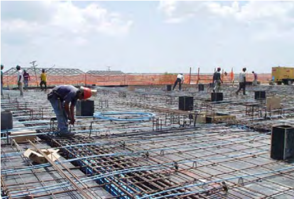
Grafico 3. Habilitado de acero para techo de concreto armado.
