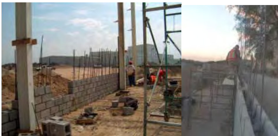
Gráfico 25. Construcción de muros utilizando bloque de concreto hueco
