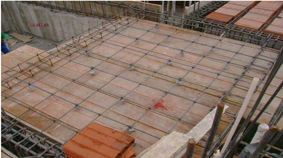
Gráfico 2. Armado de acero para un techo de concreto.
