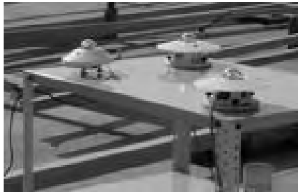
Figura 4.22. Piranómetros instalados para monitorear su respuesta
