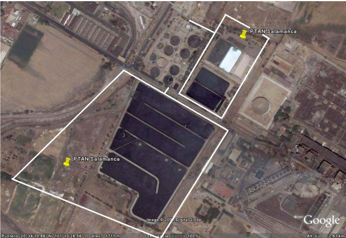
Figura 9. Espacios disponibles dentro de las instalaciones de la refinería Ing. Antonio M. Amor
