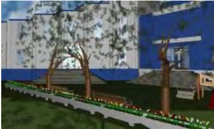
Vista de fachada de calle Miramar esq. Nayarit
