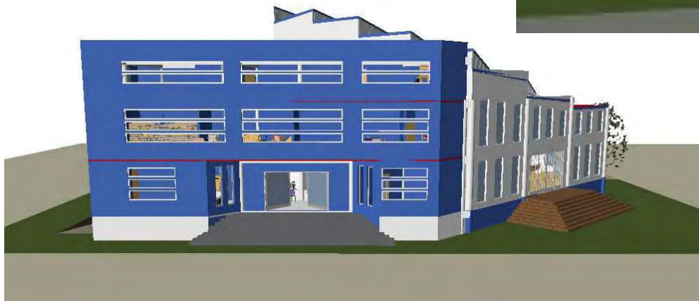
Vista de fachada de calle Marquesa. Acceso al edificio de servicios
