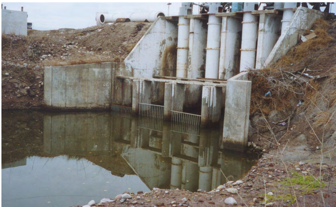
Foto 3.1. Cárcamo de bombeo.
