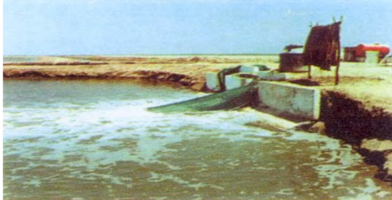
Foto 3.4. Salida al canal de alimentación.
