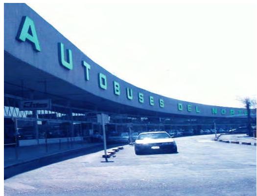
Fotografía del acceso de la central del Norte.
