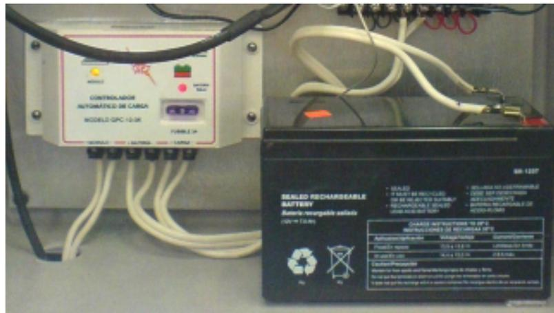
*Figura 3.18. Conexiones entre el controlador de carga y la batería en la estación remota.*
