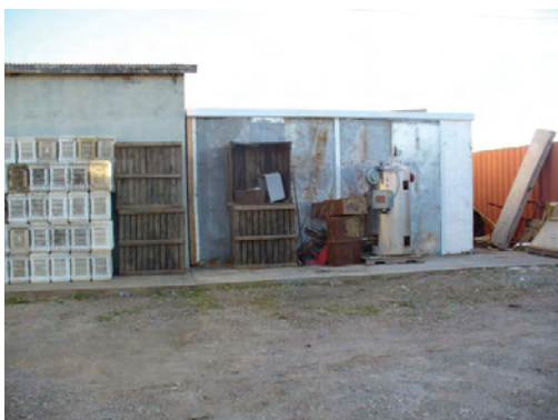
Cuarto frío exterior
