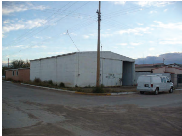
Centro de Distribución
