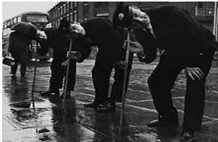
Figura 2.13 Localización de fugas mediante varillas en el Reino Unido durante la década de los 30. Éste método se sigue utilizando en ciertas regiones del mundo y en la República Mexicana (Chyuan 2007).
