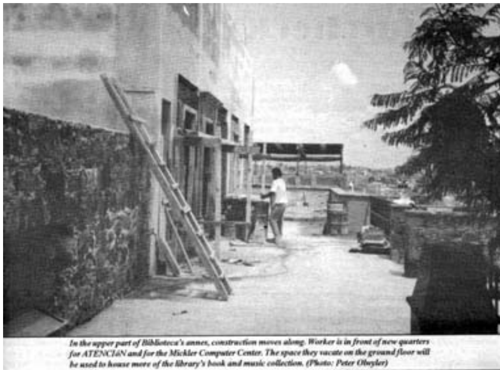
Foto 8. Trabajos de ampliación
