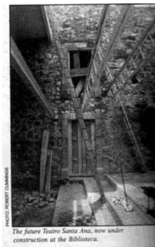
Foto 10. Trabajos de remodelación del teatro
