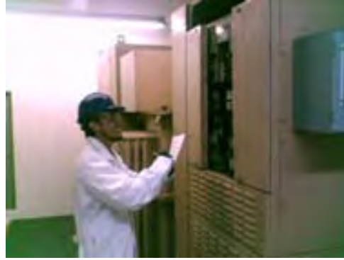
Figura 4.14 Verificación de instalaciones
