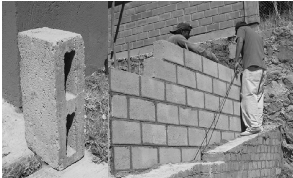
Fotografía 4. Block, muro de block aparente.
