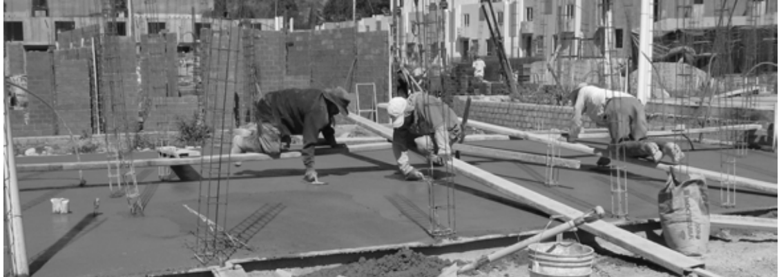
Foto 1. Losa de cimentación de concreto armado con pulido integral.
