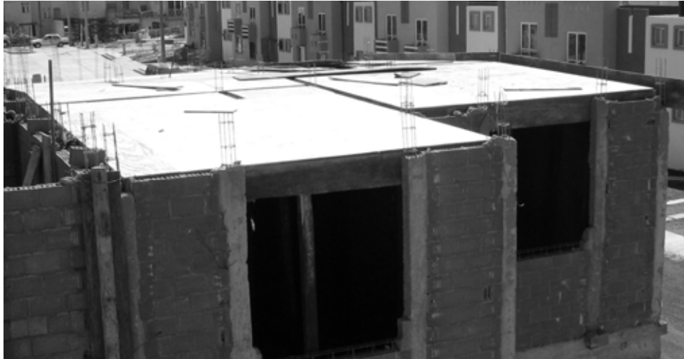
Foto 8 Cimbrado en losa de azotea.
