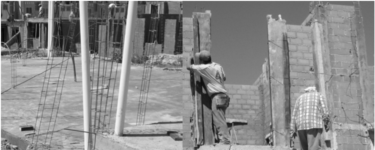
Foto 6. Armado y anclado de castillos.
