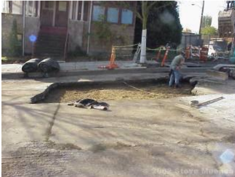
PREPARACION SUPERFICIAL DE EL PAVIMENTO EN UNA CALLE
