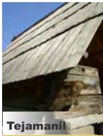
Tejamanil Tablillas de madera de oyamel, actualmente muy difíciles de encontrar.
