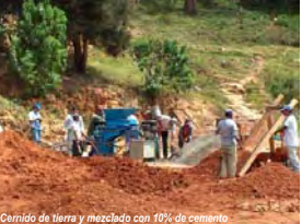
Cernido de tierra y mezclado con 10% de cemento.
