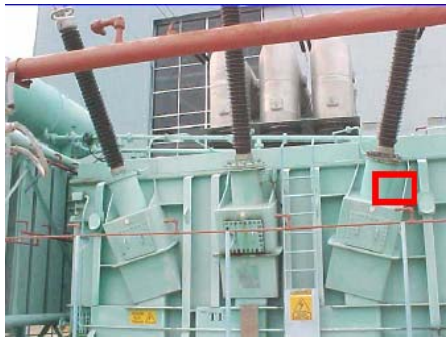
Empleo de equipo termográfico en una boquilla de alta tensión de un transformador.
