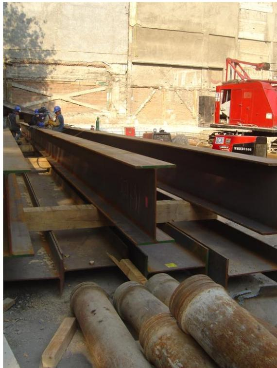
De la verticalidad y correcta ubicación en planta y profundidad de las juntas depende en alto grado el éxito de las siguientes etapas de construcción. Cuando hayan quedado debidamente colocadas las juntas, se procede a colocar los emparrillados del acero de refuerzo del muro milán.
