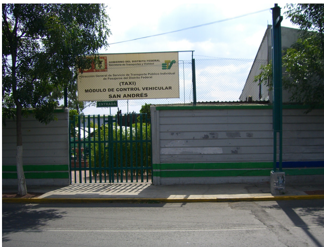
Fachada Principal del terreno.
