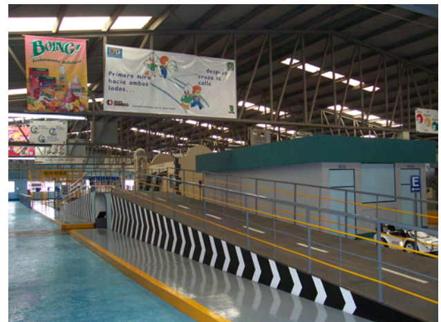
Vista del puente vehicular.
