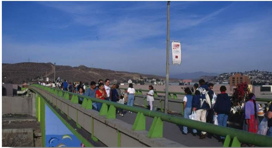
Puente peatonal (río Tijuana)
