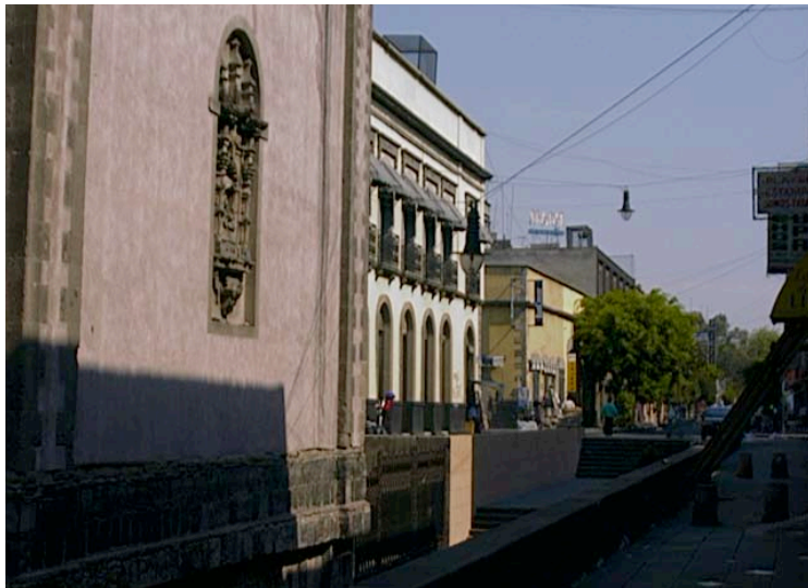
Desnivel en Emiliano Zapata
