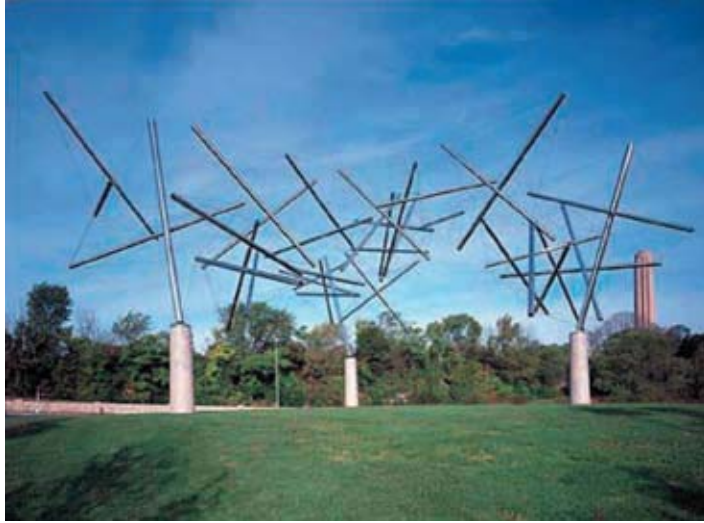
Fig.7.7. Estructura de tensegridad.
