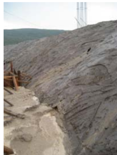
Figura III.27 Erosión de Zanjas debido a la lluvia y 28) recubrimiento de terraplenes con lechada de cemento.
