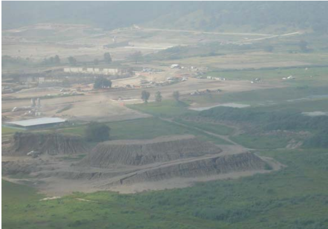
Figura III.21 Depósito de material producto de excavación
