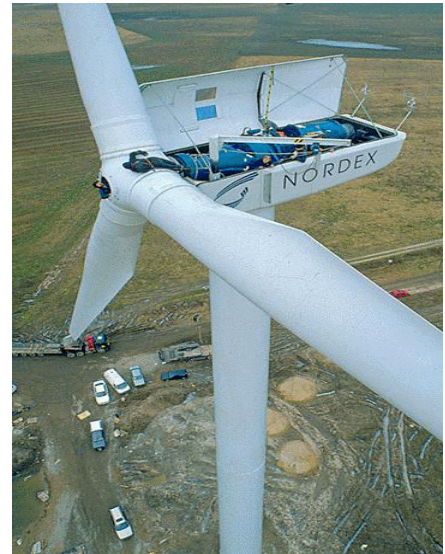
Figura 46 Armado de turbina eólica. Holanda
