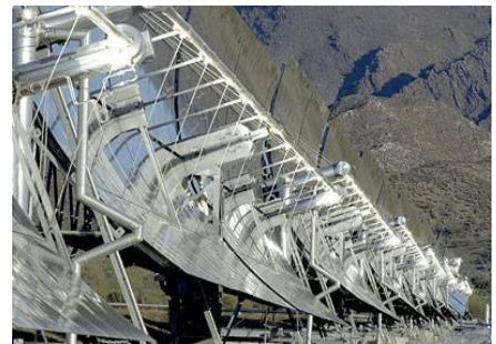
Figura 43.1 Canales parabólicos para captación de energía solar
