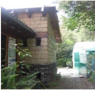
Figura 57 Vista exterior de la cocina
