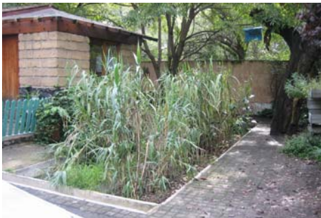
Figura 60 wet land, se utiliza para filtrar las aguas grises provenientes de lavadero, lavabo, regadera, fregadero, lavadora,
