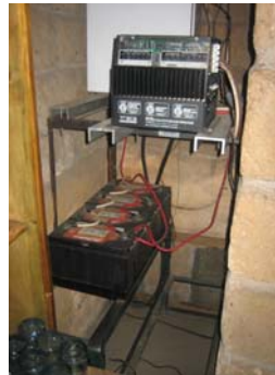
Figura 67 Convertidor ene. alterna a ene. directa. Red eléctrica gen. de la casa.
