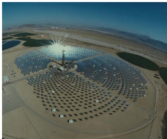
Figura 43 torre de concentración de energía solar, utilizado en para pruebas de laboratorio que requieren altas temperaturas.
