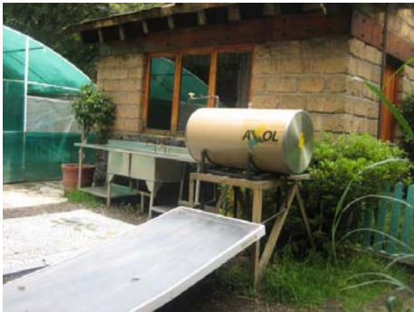
Figura 66 Termo tanque, utilizado para calentar agua
