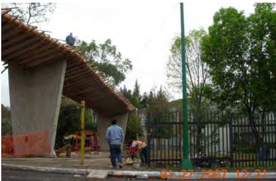
Imagen 4.3 Construcción del primer puente elevado peatonal dentro de las instalaciones de CU, éste fue inaugurado en marzo 2007
