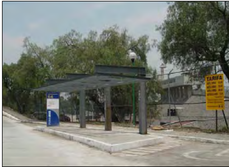
Imagen 6.9 Proceso de modernización de los estacionamientos del Estadio Olímpico Universitario, febrero 2007.
