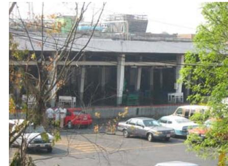
En este centro de abastecimiento observe desde los materiales con que fue realizado el complejo hasta los utensilios y equipos con que cuenta , en este rastro la zona de carga y descarga esta totalmente cubierto de losa de concreto armado, el piso es de concreto pulido, columnas de concreto armado no hay protección en paredes, existe un entramado de vigas de acero sobre del cual va una red de rieles la cual se usa para sostener la carne
