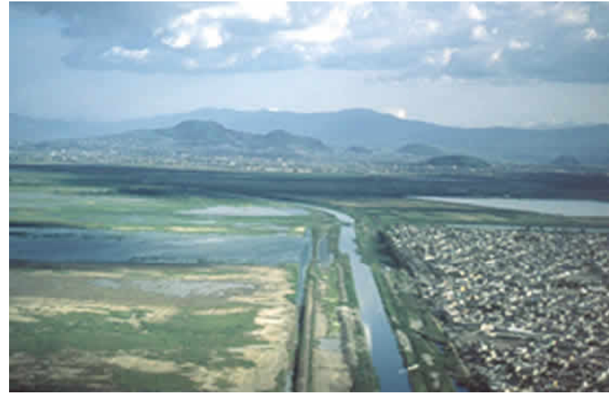
Ex-Lago de Texcoco, Canal de las Sales y Ciudad Azteca, al fondo la Laguna de Regulación Horaria. Vista hacia el sur.
