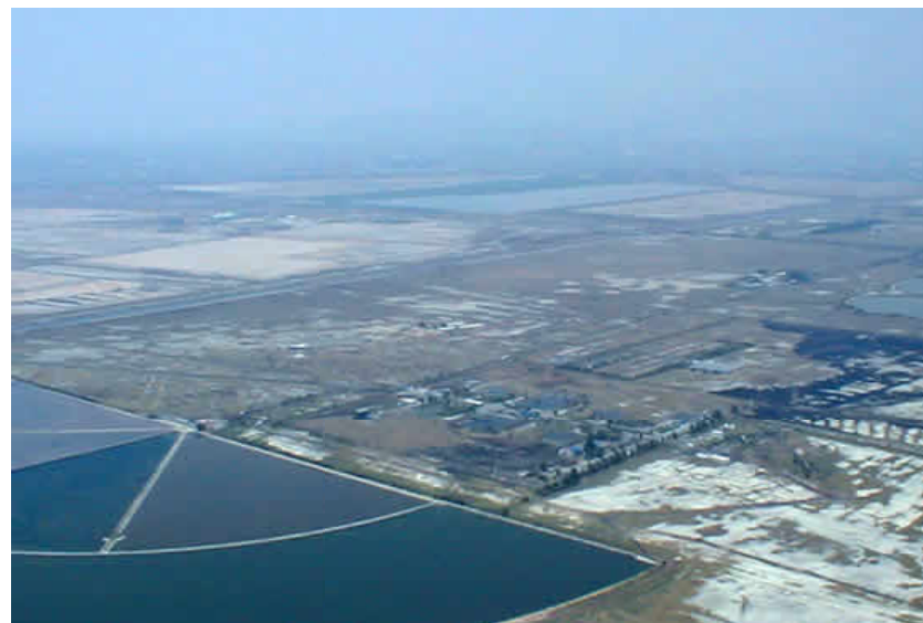
Plantas de Tratamiento de Lagunas Facultativas y de Lodos Activos, al fondo la Laguna de Regulación Horaria.
