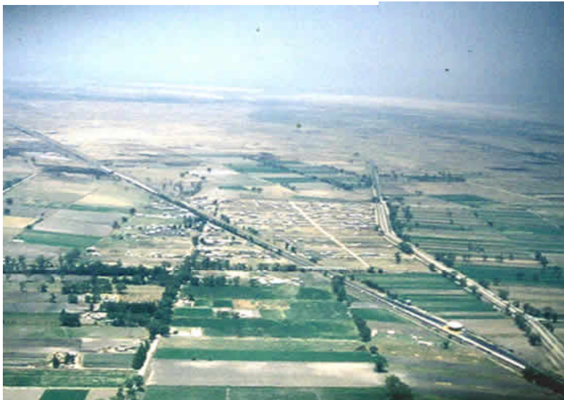
Autopista Peñón-Texcoco vista desde la caseta de Texcoco hacia la Zona Federal.
