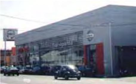
La envolvente externa, será tratada con frontones metalizados, cristal, el acceso con sus respectivas características el nombre de la agencia así como un emparrillado de tubos que sirven de transición entre el cristal y los elementos sólidos, aquí el ejemplo de la NISSAN TLALNEPANTLA.
