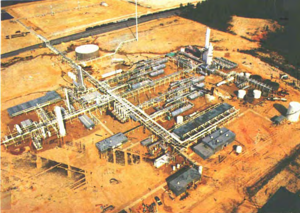
F.I.3 Vista general de la distribución de "racks" en una planta
