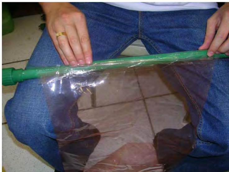
Figura 3.3. Pegado del material aislante
