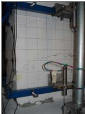
Fig. 1.6 Grietas debido a la flexión en las caras perpendiculares a la dirección del actuador
