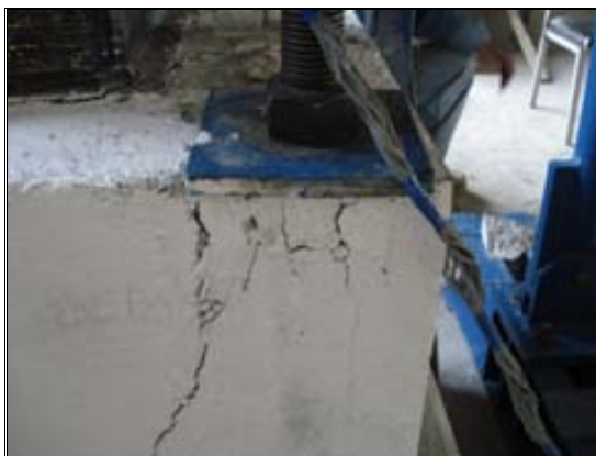
Fig. I.20 Agrietamientos en la base del espécimen
