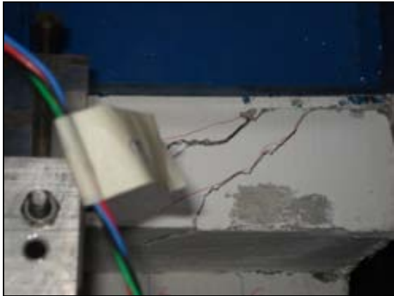
Fig. 1.4 Grietas debido a la concentración de esfuerzos en el cabezal
