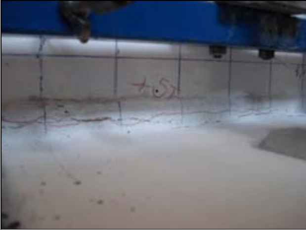
Fig. I.12 Grietas debido a la flexión en las caras perpendiculares a la dirección del actuador
