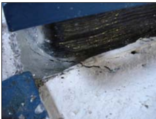
Fig. I.17 Agrietamientos en la unión del espécimen y la base
