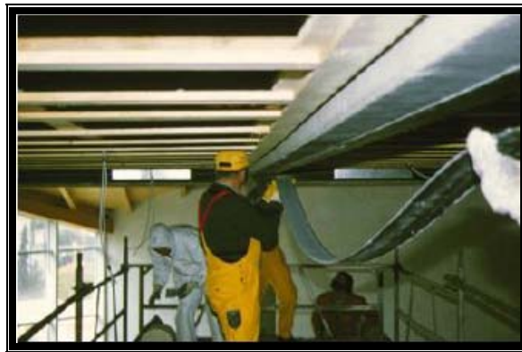
Fig. 2.5.1 Colocación de refuerzo por flexión
