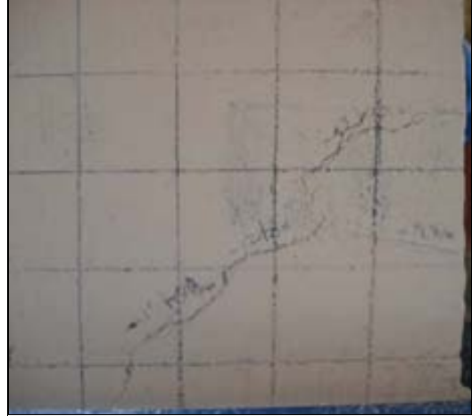
Fig. I.13 Grietas debido a la acción de fuerzas cortantes en las caras paralelas a la dirección del actuador
