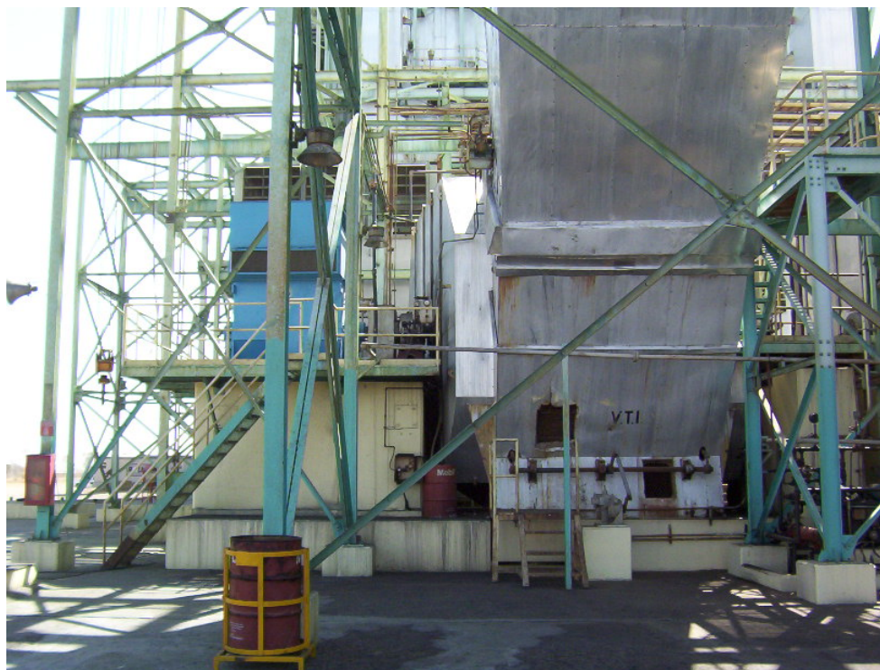
Fotografía N° 3. Vista lateral del VTI y su cimentación
