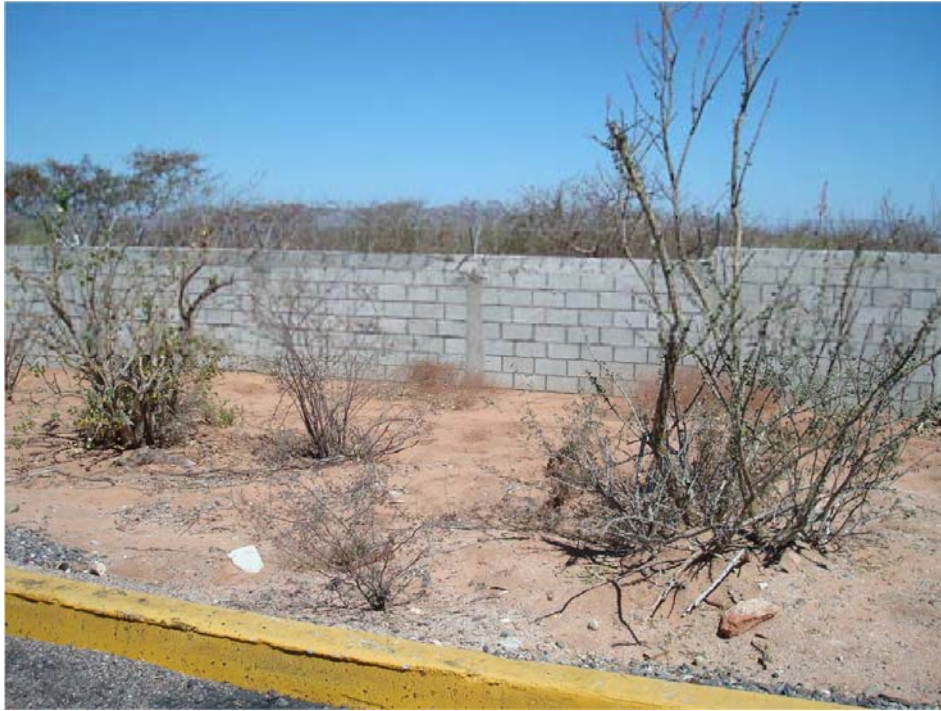
Fotografía 9. Zona de amortiguamiento y barda perimetral
