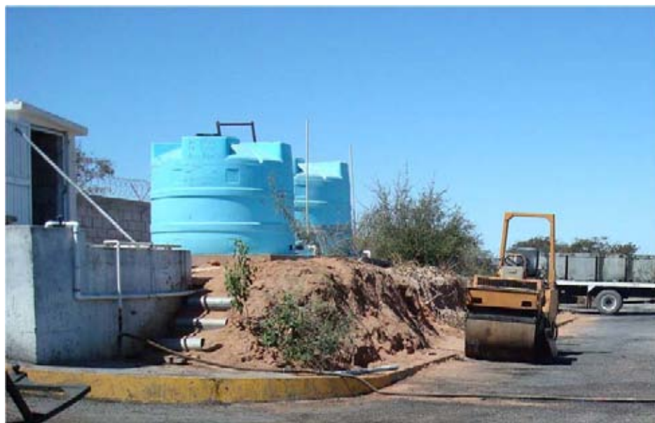
Fotografía 8. Aplanadora para apisonar la ceniza
