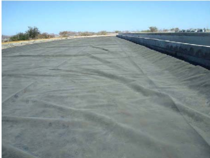
Fotografía 5. Vista de la geomembrana que recubre la zona de confinamiento
