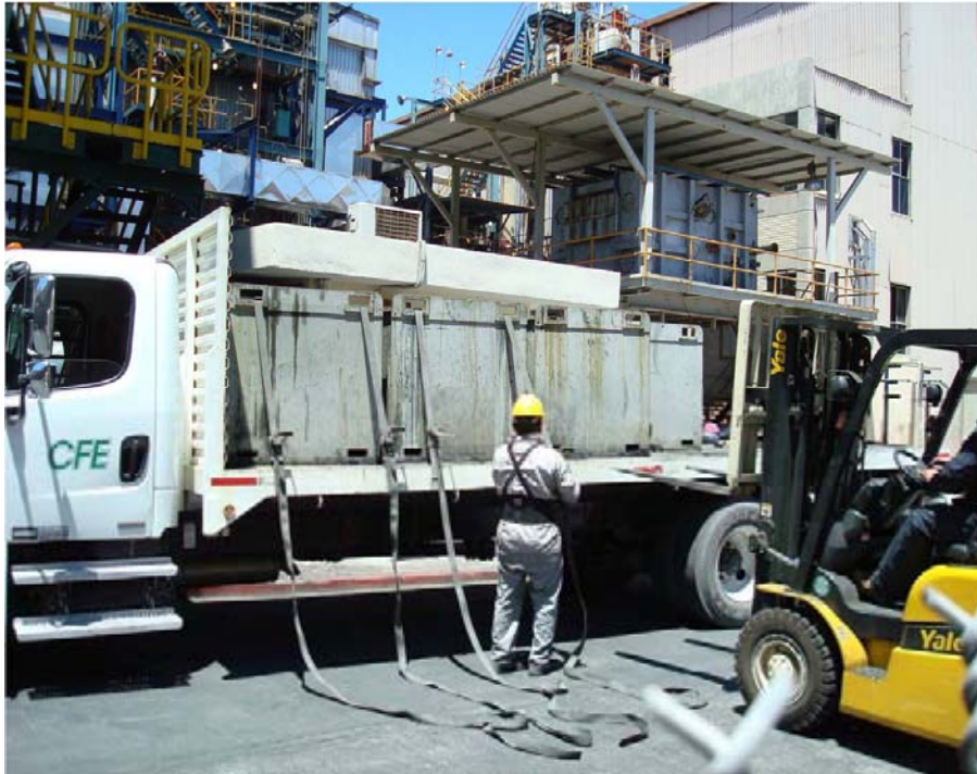
Fotografía 3. Ajuste de los contenedores de ceniza para su manejo seguro
