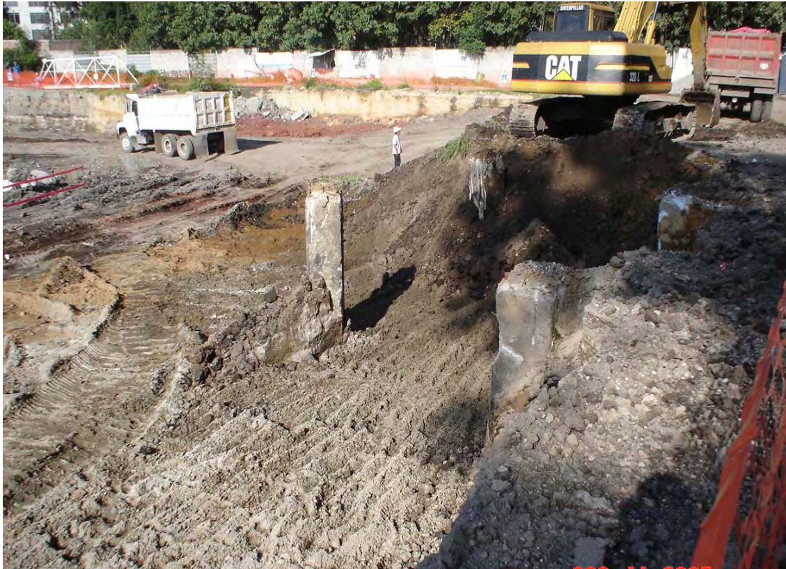
Deshabilitado de la cimentación anterior
