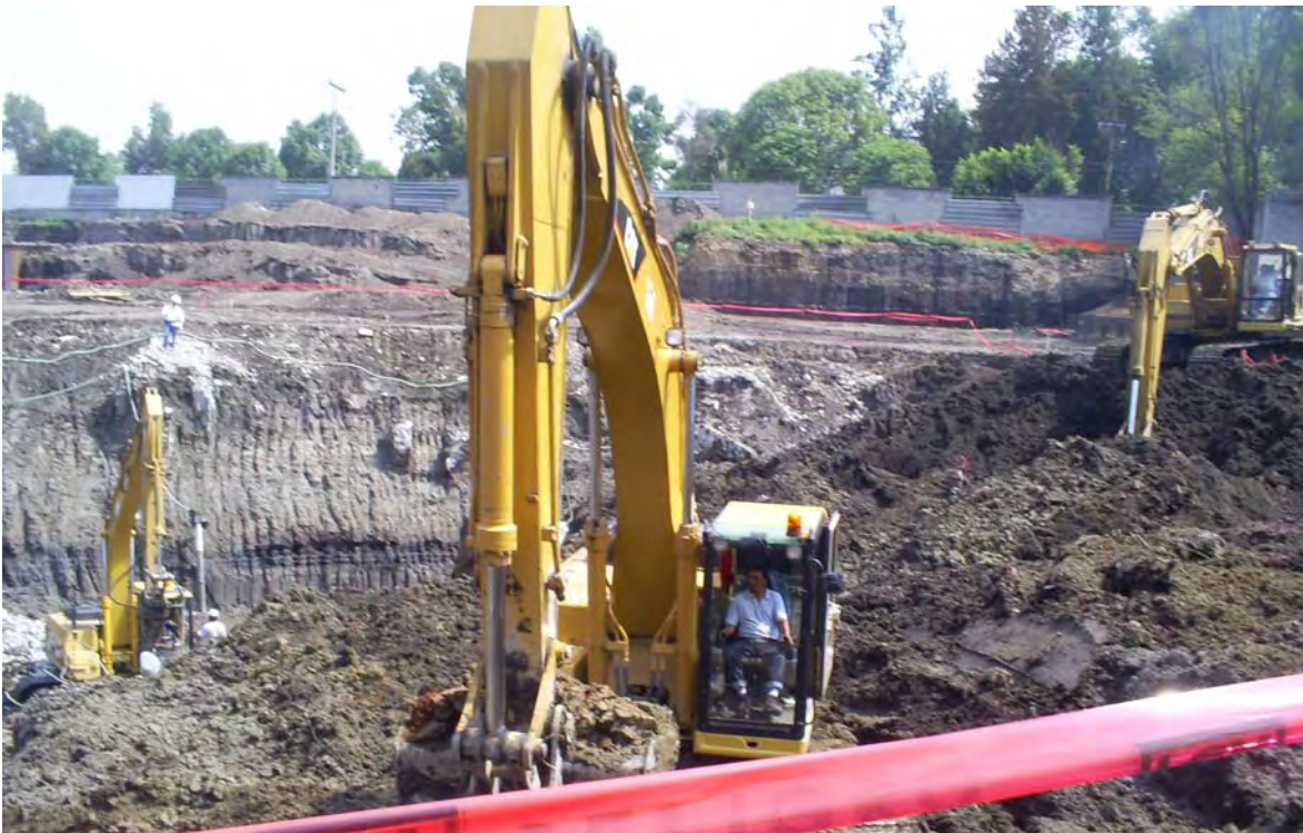
Excavación de etapas interiores
