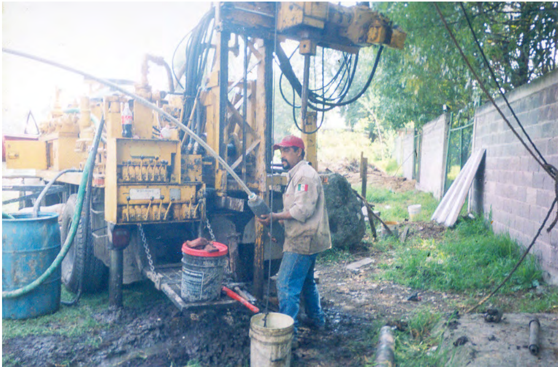
INSTALACIÓN DEL PIEZÓMETRO ABIERTO "TIPO CASAGRANDE"
