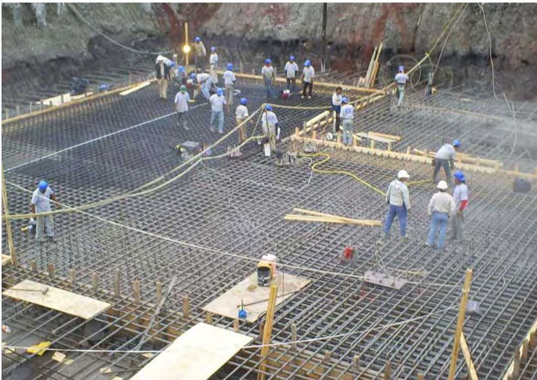
Colado por etapas del cajón la losa de cimentación
