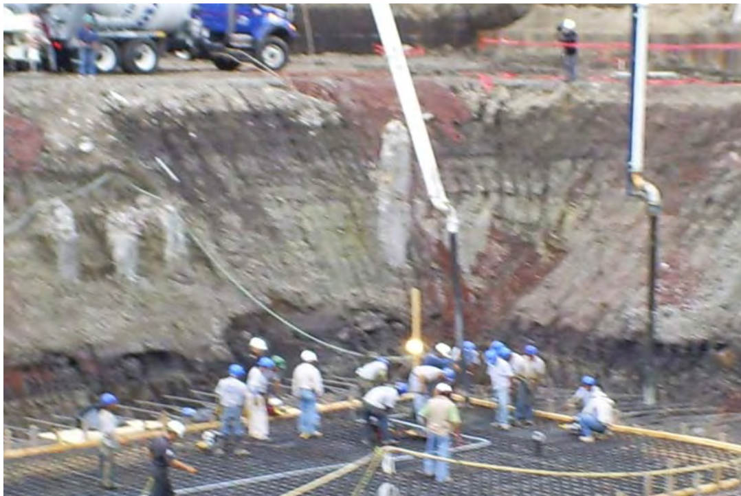
Bombeo y colocación de concreto
