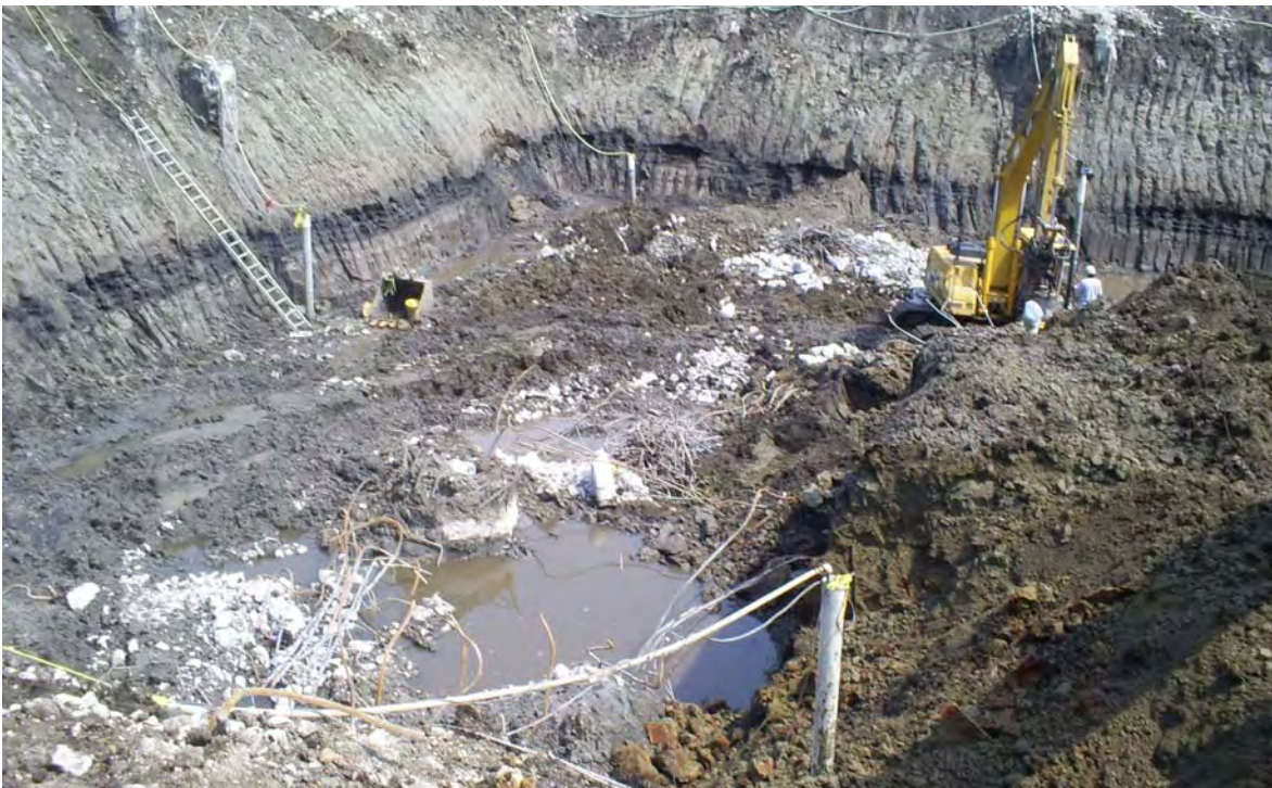
Excavación de etapas perimetrales
