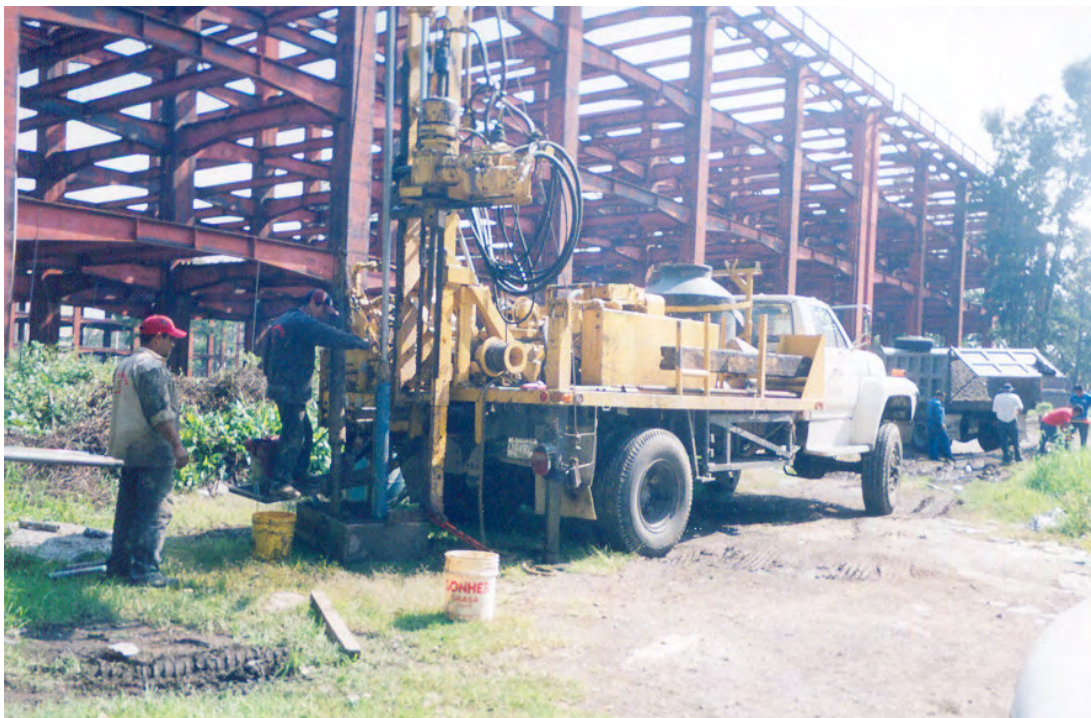
TRABAJOS DE PERFORACIÓN DEL SONDEO MIXTO SM-1
