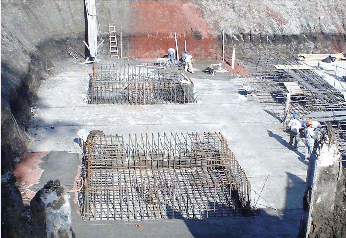
Armado de los dados de las zapatas
