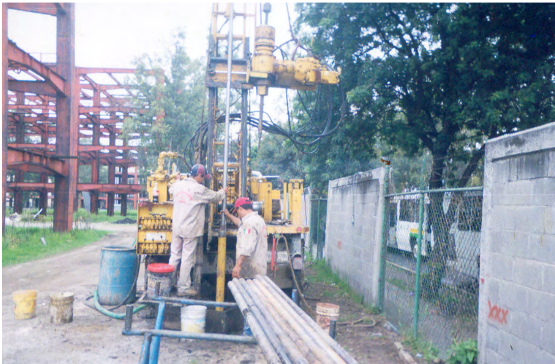
TOMA DE MUESTRAS INALTERADAS UTILIZANDO EL TUBO SHELBY
