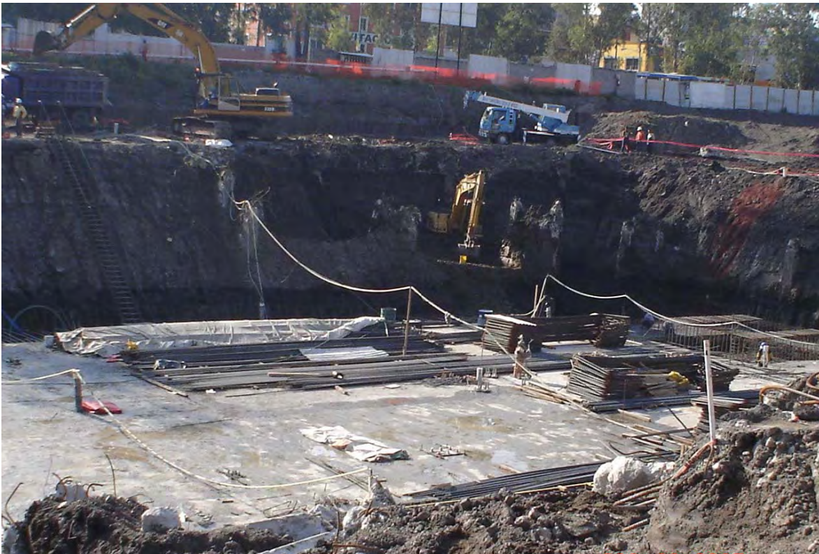
Colado central de la losa
