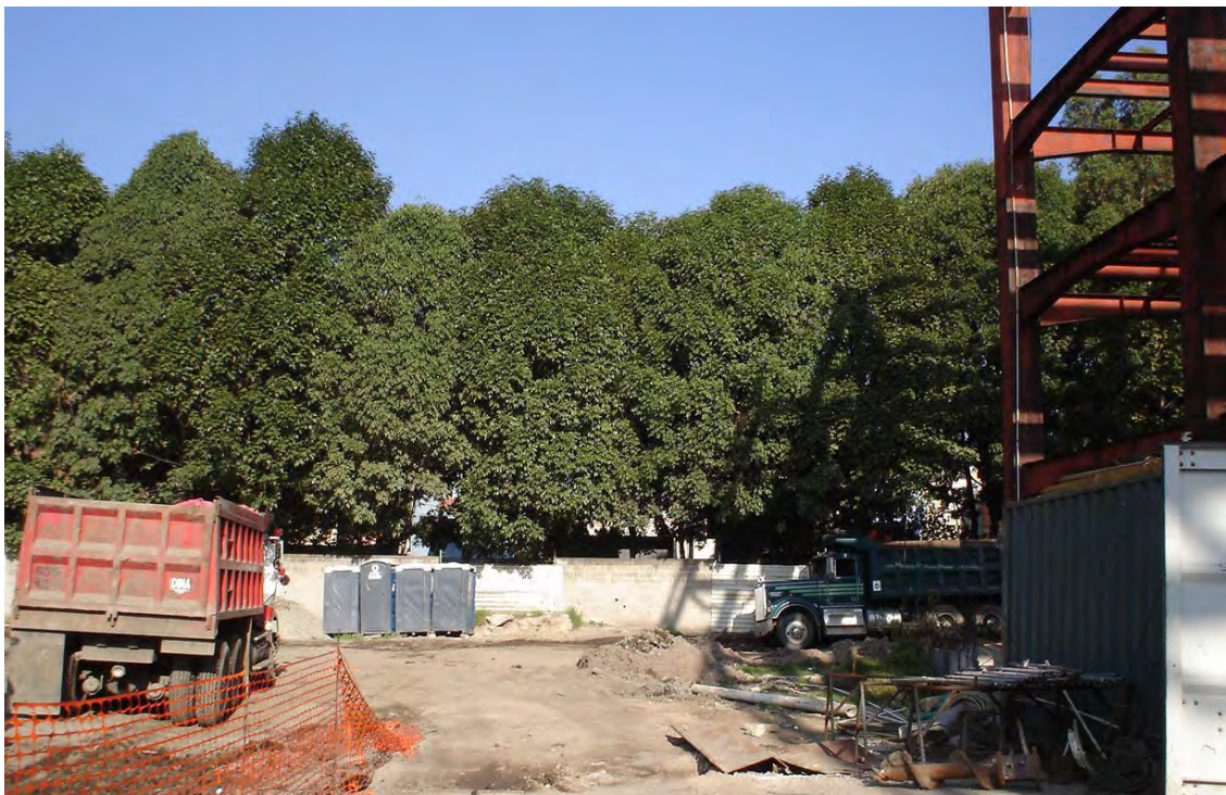
Por estos árboles se detuvo la obra 6 meses
