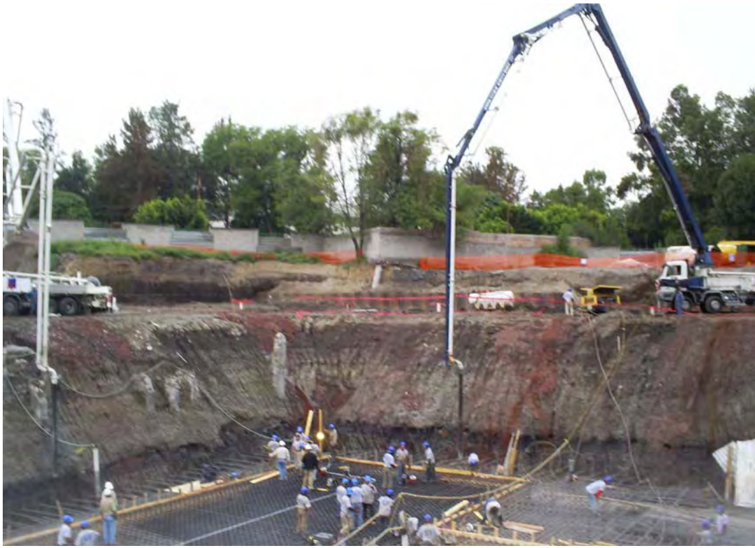
Bombeo y colocación de concreto
