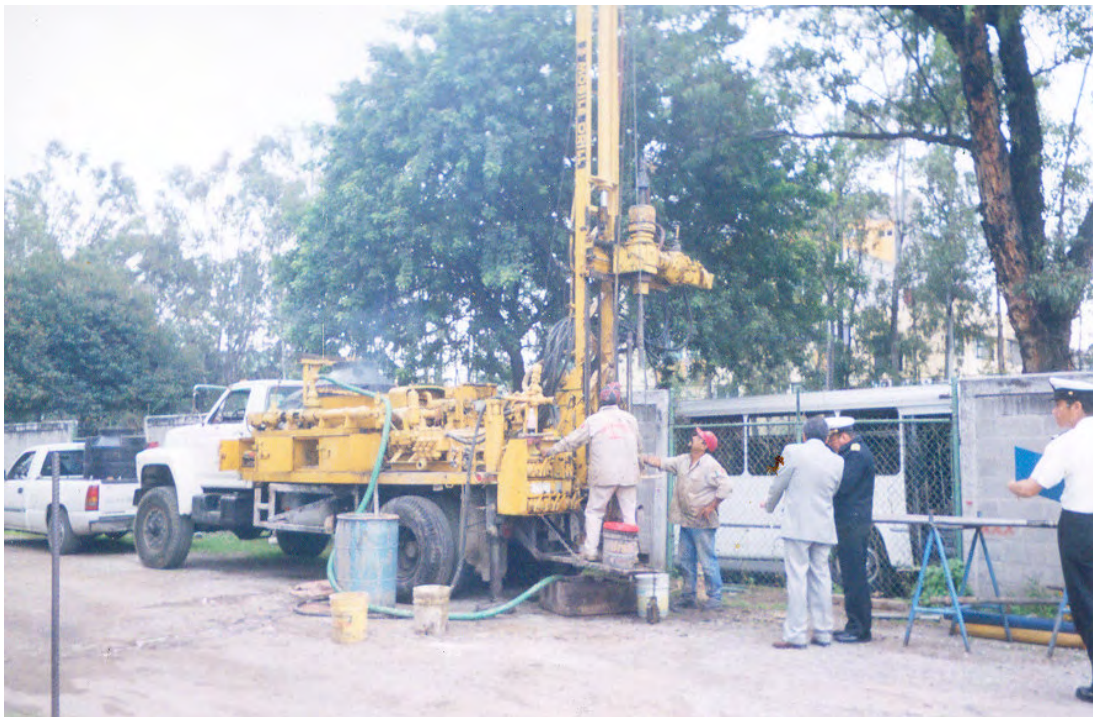
TRABAJOS DE EXPLORACIÓN GEOTÉCNICA POR MEDIO DEL SONDEO MIXTO SM-2
