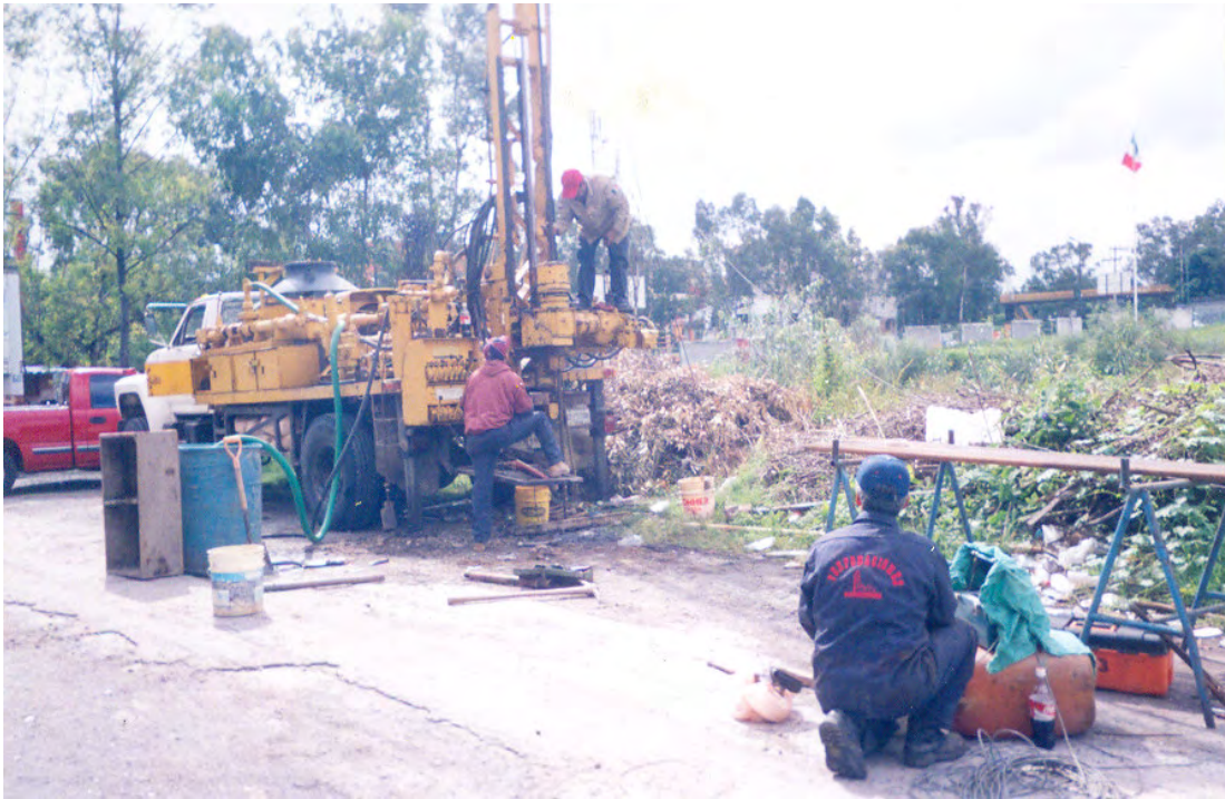
SONDEO DE EXPLORACIÓN GEOTÉCNICA UTILIZANDO EL CONO ELÉCTRICO
