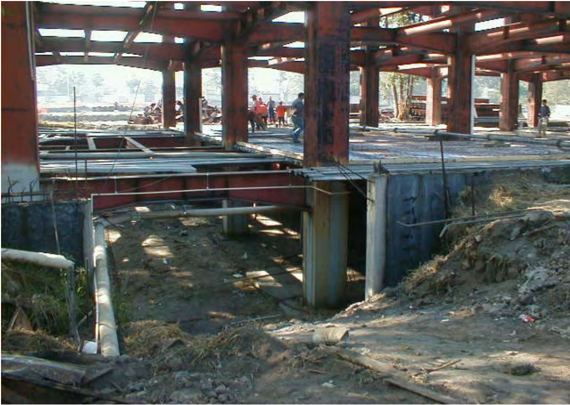
Cimentación de los edificios existentes
