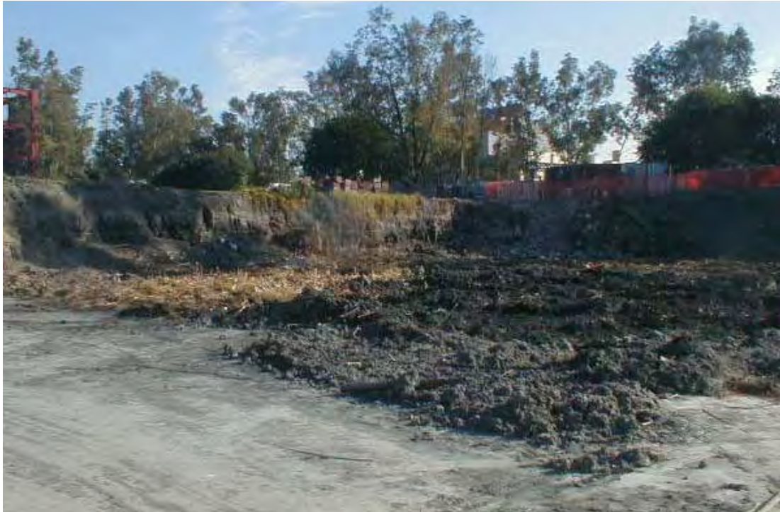
Desmante del armado de la cimentación
