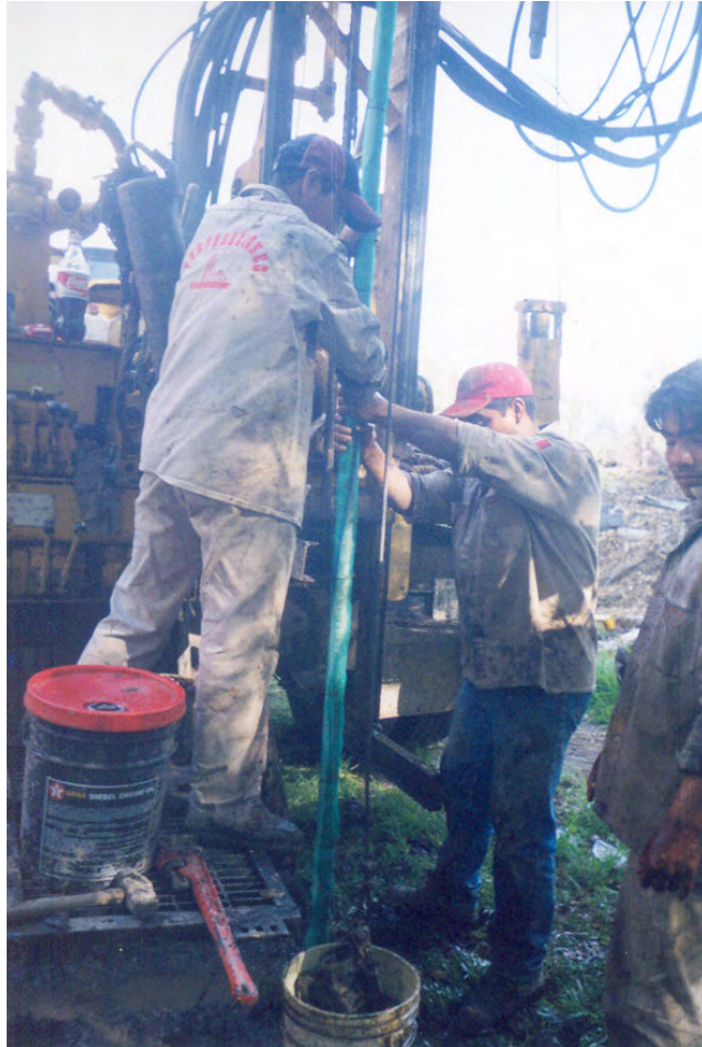
INSTALACIÓN DEL POZO DE OBSERVACIÓN DE LA ESTACIÓN PIEZOMÉTRICA
