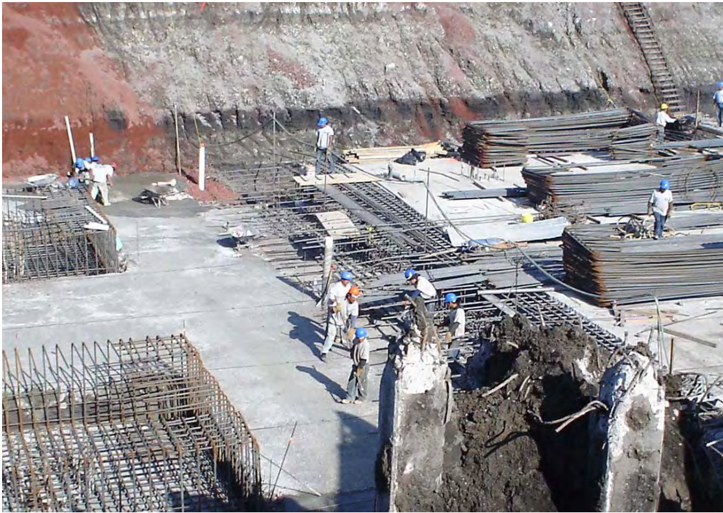
Armado de zapatas y retiro de la cimentación existente
